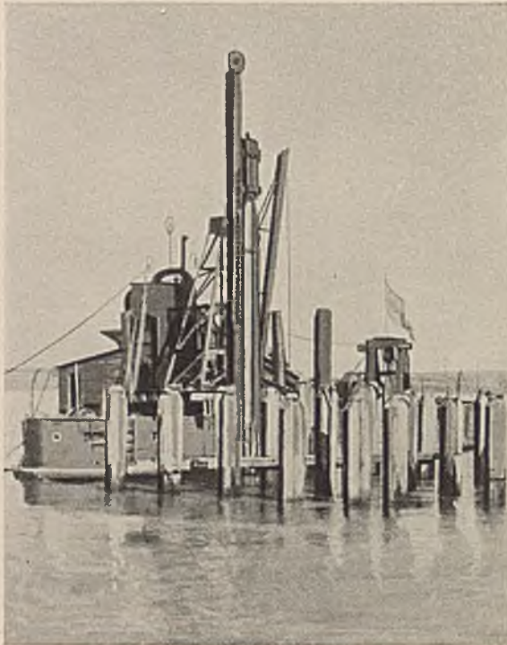
Abb. 168. Pfahlhammer in Tätigkeit.
