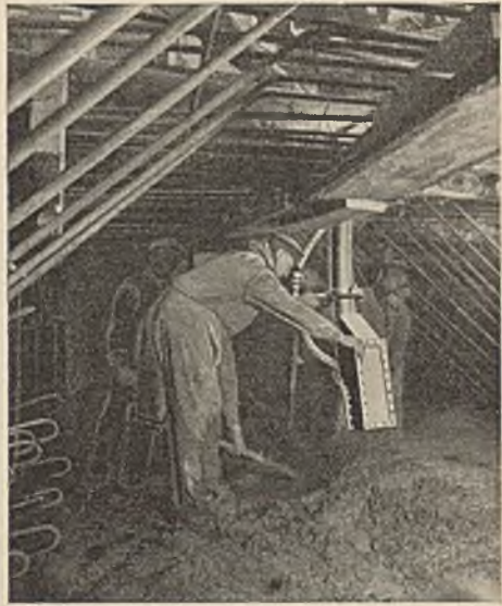
Abb. 153. Pneumatische Betonförderung. System „Torkret“.
