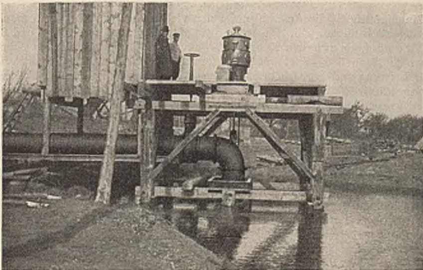
Abb. 94. Schraubenschaufler in Betrieb.
