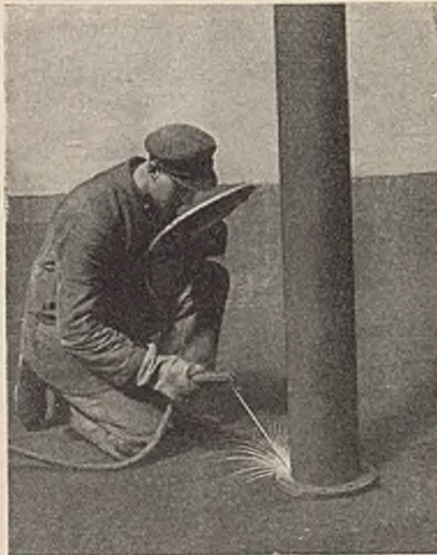
Abb. 118. Lichtbogenschweißung und ihre Zubehörtelle. (Siemens-Schuckert-Werke.)
