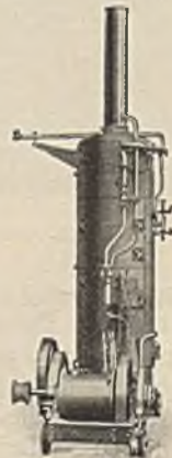
Abb. 165. Dampf kessel mit Winde für Dampf- rammen (ebenso wie Abb. 162, 163, 164 Menck und Hambrock, Altona).
