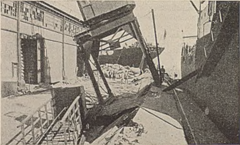
Abb. 223. Durch Erdbeben zerstörte Kalmauer in Yokohama.
