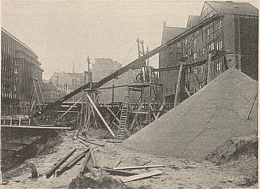
Abb. 66. Bandförderanlage für Baustoffe.
