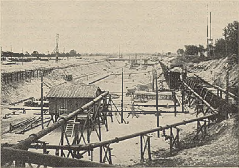
Abb. 201. Grundwassersenkungs-Rohrnetz für Schleusenbau, Hüntel; Saugrohre in zwei Staffeln und Druckrohre.
