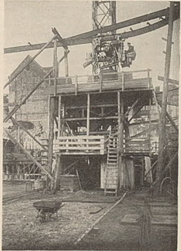
Abb. 68. Elektroflaschenzug mit Führersitz.
