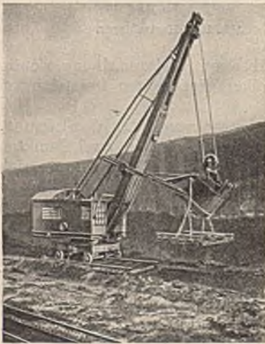
Abb. 111. Bagger, Gleis vorbauend.
