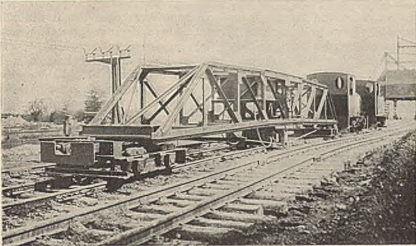
Abb. 112. Gleisrückmaschine, Bauart Arbens-Kammerer. (Siemens Bauunion.)
