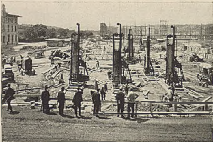
Abb. 64. Anwendung der Grundkörpermaschine von Stern. (Bauingenieur 1927.)
