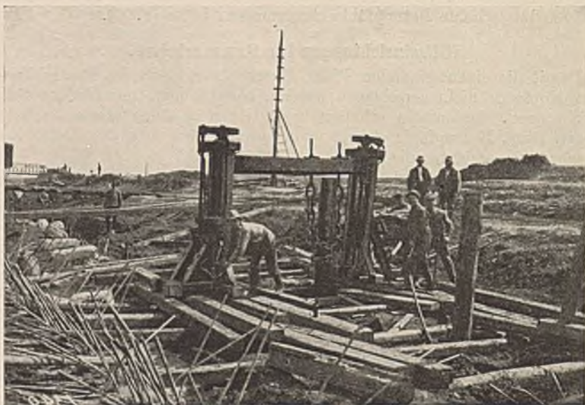
Abb. 174. Spindelhebebock zum Pfahlausziehen.
