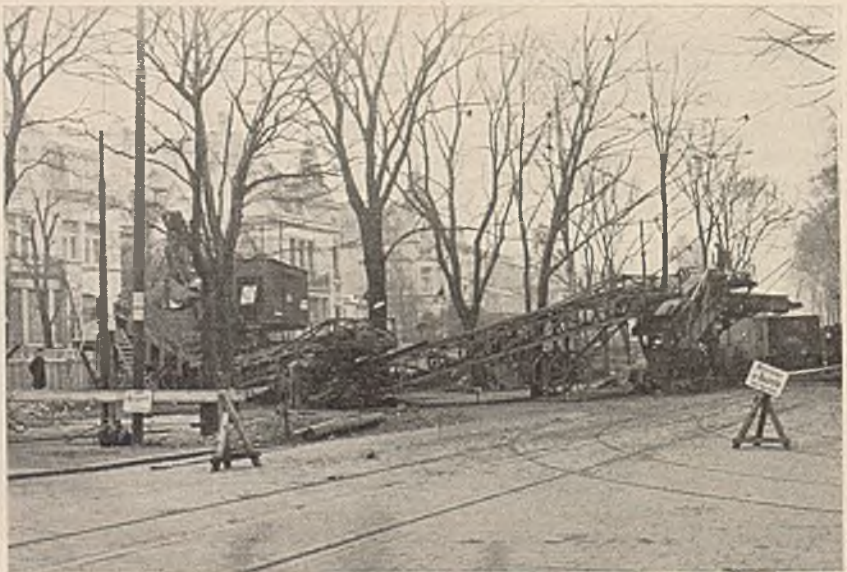
Abb. 67. Bandförderanlage für Bodenaushub.
