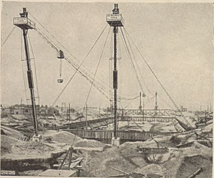
Abb. 57. Kabelkräne über einer Baugrube (nach Z. V. D. I. 1927).
