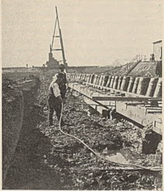
Abb. 124. Preßluftbohrmaschine auf der Baustelle.
