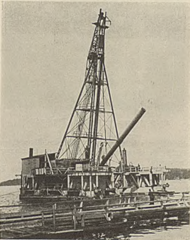
Abb. 84. Ramme für die Lidingsbrücke.
