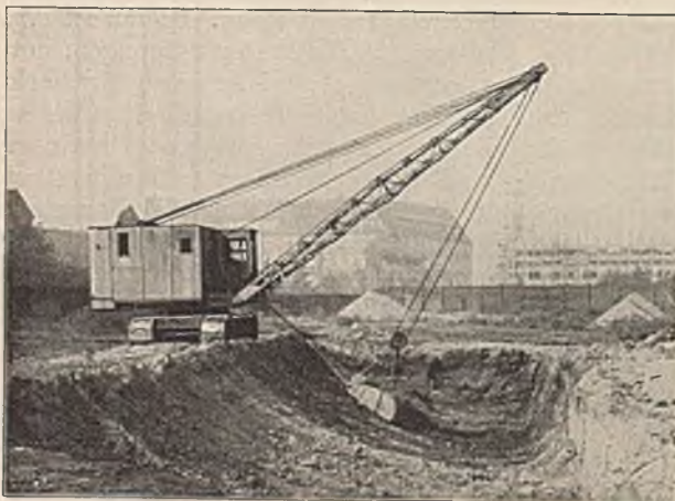
Abb. 105. Eimerseilbagger an der Baugrube.
