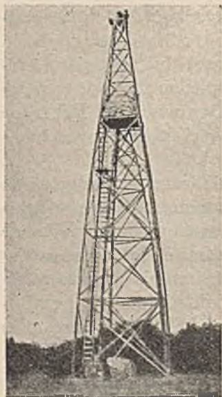
Fig. 30. Wieża triangulacyjna z nadbudową.
