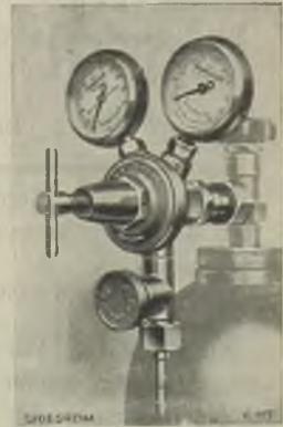
Abb. 126. Sauerstoff-Reduzierventil. (F. G. Farbenindustrie, A.-G., Werk Lützelheim, Griesheim a. M.)
