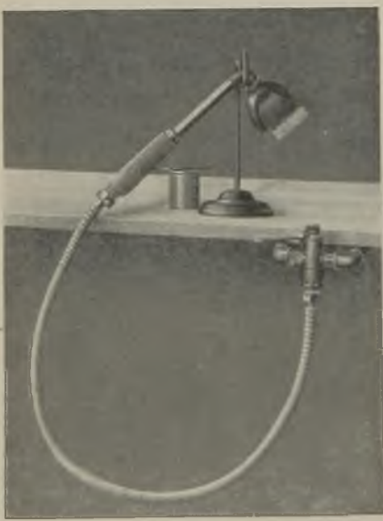
Abb. 210. Pharos-Lötkolben mit Preßluft-Gasbeheizung. (Pharos-Feuerstätten, Hamburg 1.)
