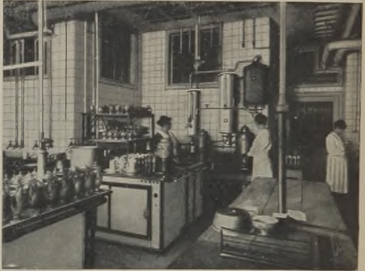
Abb. 522. Kombinierte Anlage von Junkers-Heißwasserapparaten in der Kaffeeküche eines großen Hotels.
