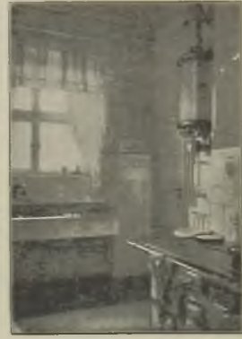
Abb. 512. Prof. Junfers' Stromautomat, als Warmwasser-Quelle für den ganzen Haushalt in der Küche an die Wand gehängt. (Beim Aufdrehen des Heißwasser-Hahnen entzünden sich selbsttätig die Brennerflammen, beim Zudrehen des Hahnen verlöschen sie von selbst.)
