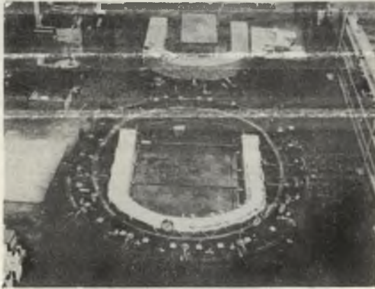
Rys. 22. Badania obudów murowych w stoisku
