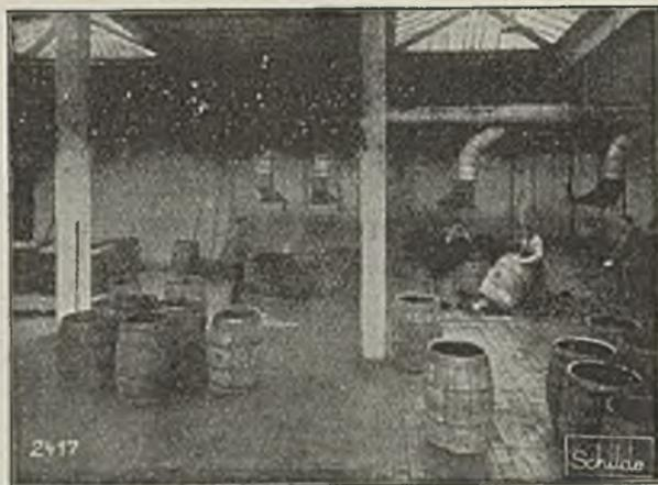
Abb. 88. »Schilde«-Entnebelungsanlage in einer Färberei.
