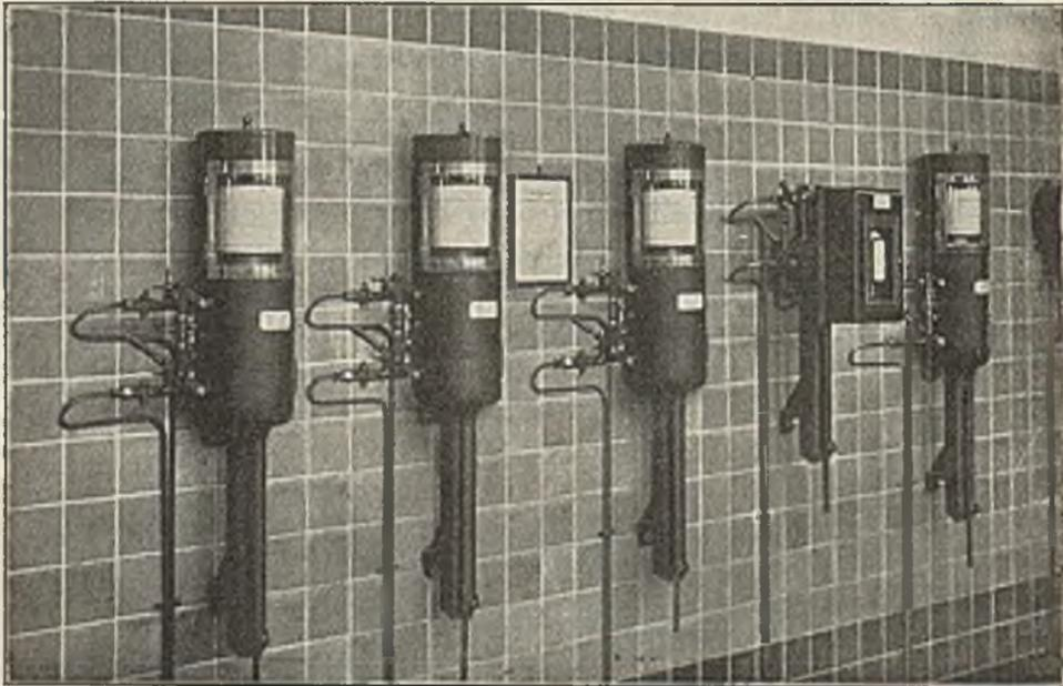
Abb. 137. Bopp & Reuther-Selbstschreiber im Großkraftwerk Zschornowitz.
