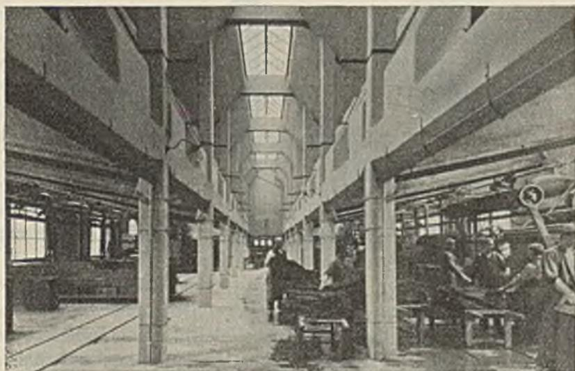
Abb. 94. Als Betonbau ausgeführte Stückfärberei mit eingebauter Entnebelungsanlage, Bauart „Dr. Bauer“.
