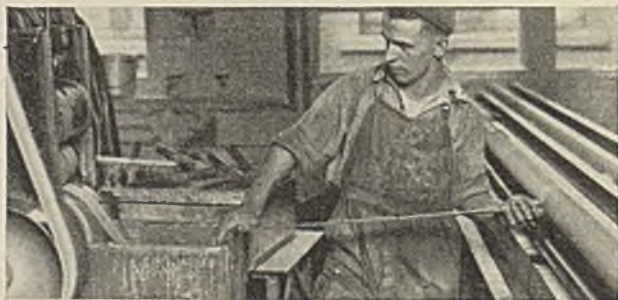
Abb. 379. Einwickeln der Schläuche Abwickeln der Stoffstreifen von Holzdnornen
