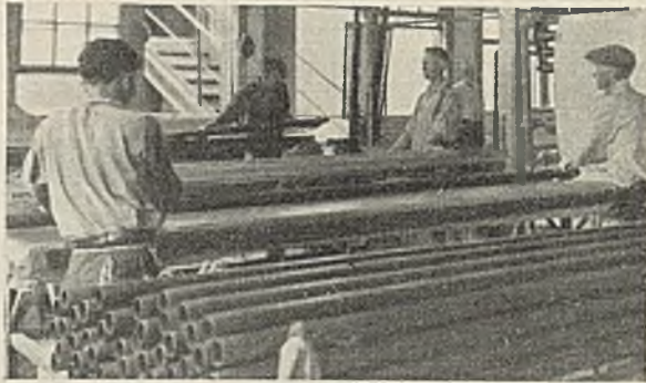
Abb. 373. Rollen und Einwickeln der Schläuche. Teilweise Fließarbeit
