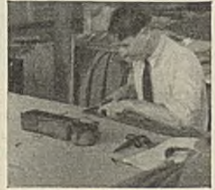
Abb. 385. Abschrägen der Schlauchenden von Hand aus
