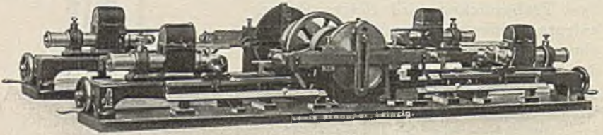
Abb. 42. Schopper-Dauerzug-Versuchsmaschine nach Martens
