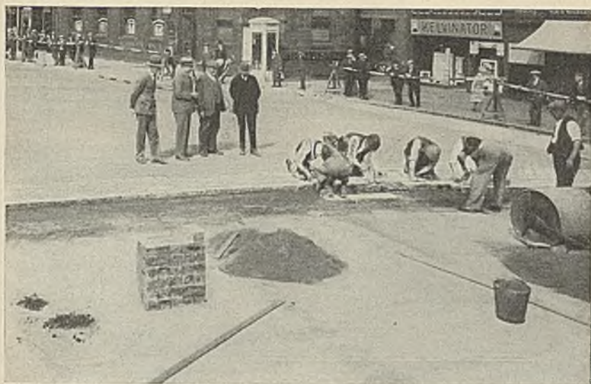
Abb. 885. Verlegung in Huddersfield
