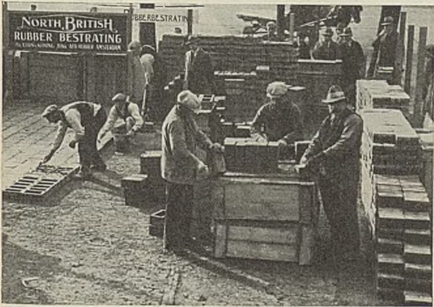
Abb. 889. Verlegung von »North-British« Blöcken in Rotterdam
