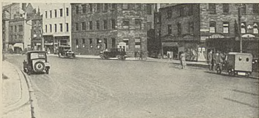
Abb. 886. Huddersfield nach dem Verlegen
