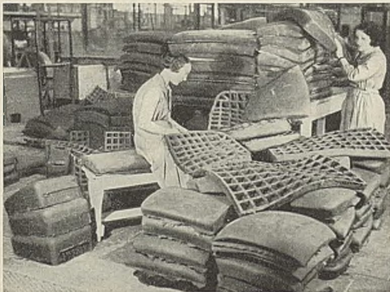
Abb-854. Kontrolle und Beschneiden geformter Latexschwammsitze
