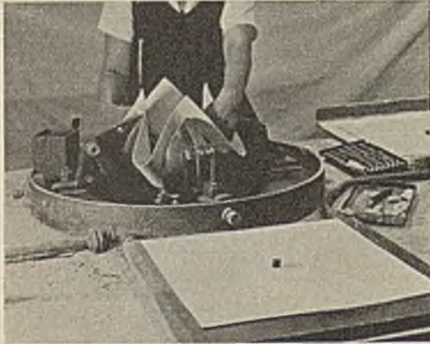
Abb. 609. Einlegen des Zuschnittes in die Eccles-Ballmaschine
