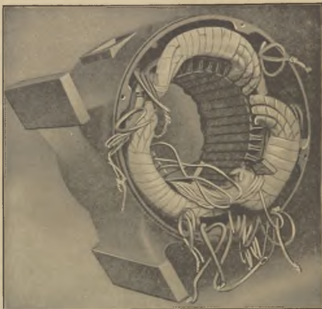
Fig. 77. Drehstrom-Ständer mit 3 eingewickelten unteren Gruppen und eine im Entstehen begriffene obere Gruppe.
