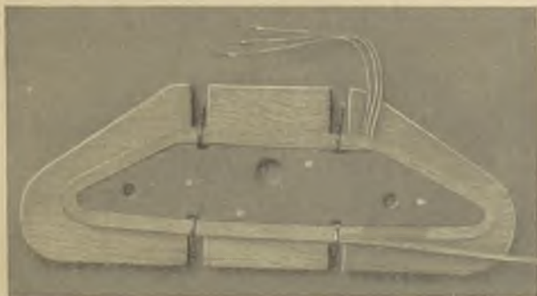
Fig. 35. Anker-Formspule in der geöffneten Schablone.
