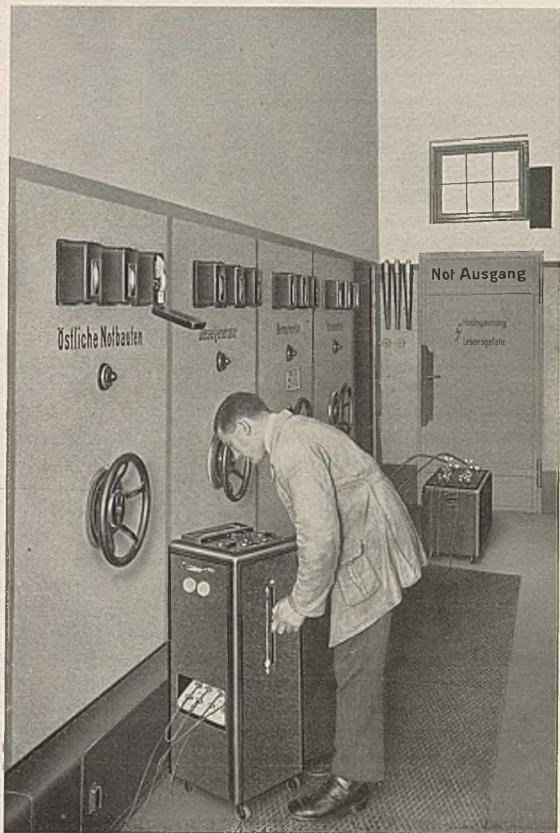
Bild 427. Relaisprüfeinrichtung im Betrieb.
