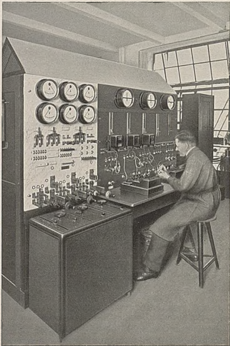
Bild 177. Wechselstrom-Zählerprüfeinrichtung mit davorgesetztem dreiphasigen Regeltransformator.
