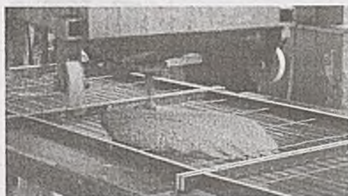
Fot. 3a. Betonowanie płyt
