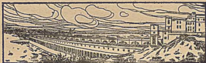
Ryc. 4. Stacja wodno-elektryczna na rzece Tennessee.
