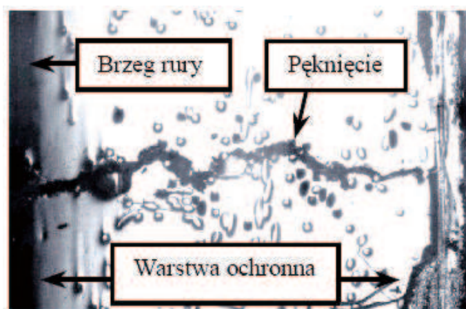
Rysunek 2.8. Pęknięcie warstwy ochronnej rury poliestrowo- szklanej [66]
