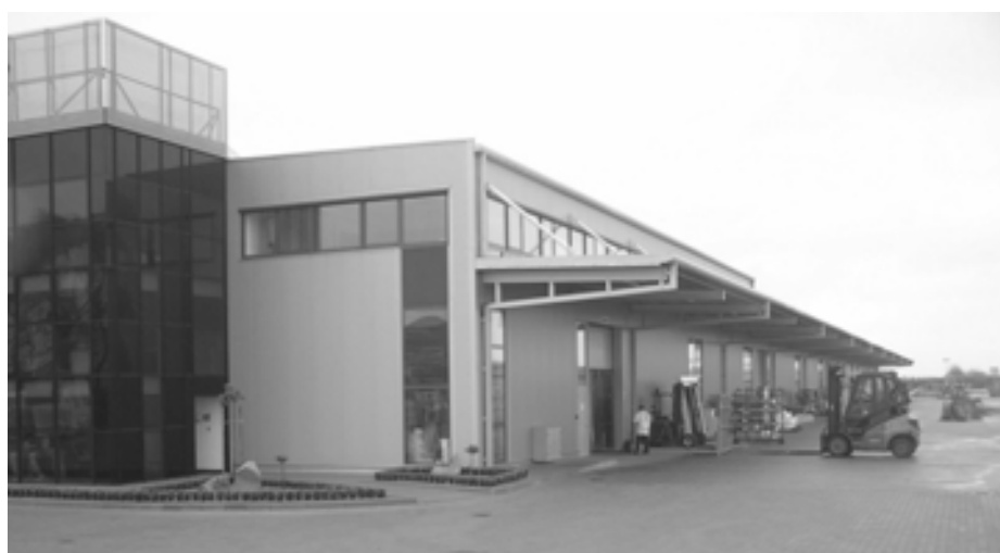
Rys. 14.2 Nowa hala PCV
