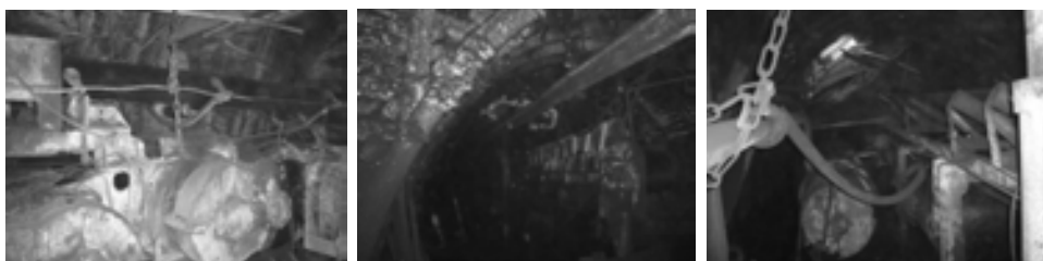
Rys. 16.1 Widok fragmentów przenośnika taśmowego w warunkach dołowych
