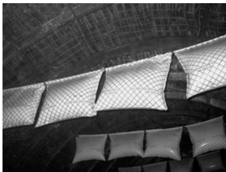
Rys. 4.3 Zapora przeciwwybuchowa wodna typu torby wodne – zwykła
