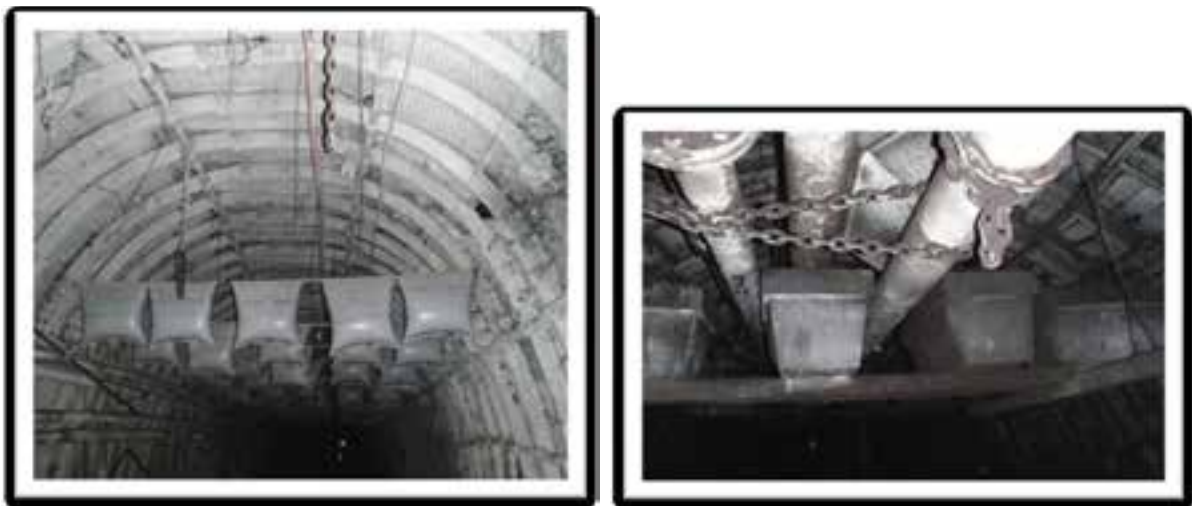
Obr. 3.1 Uzávěra s vodními vaky, vlevo, a s vodními korýtky, vpravo [8]
