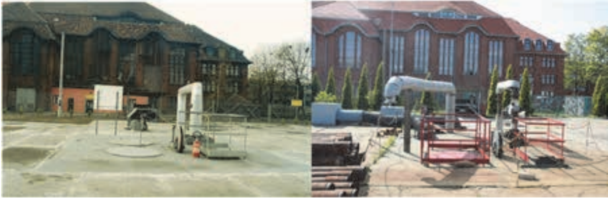
Rys. 11.2 Pompownia przed i po rewitalizacji budynku maszynowni [11]
