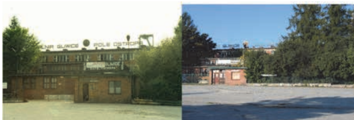
Rys. 11.5 Budynki na Polu „Ostropa” przed i po likwidacji kopalni [11]
