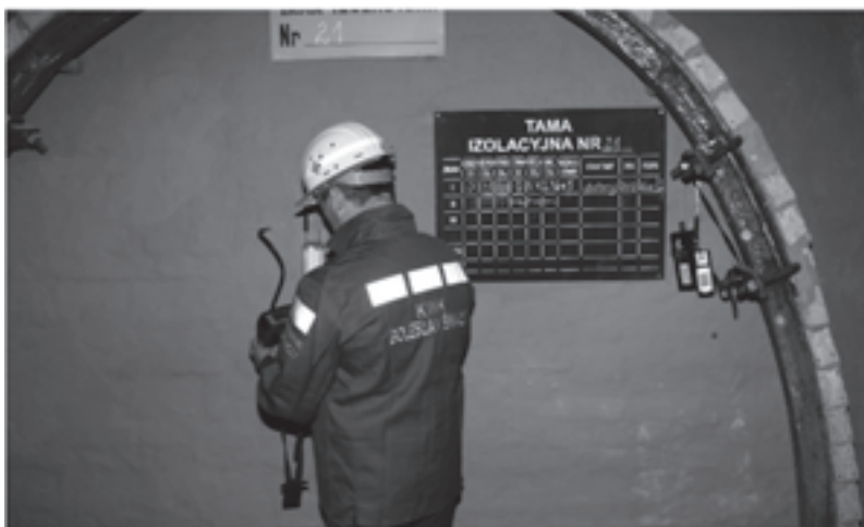
Rys. 21.12 Stanowisko do pobierania prób powietrza, pomiaru składu atmosfery za tamą i pomiaru różnicy ciśnień przed i za tamą
