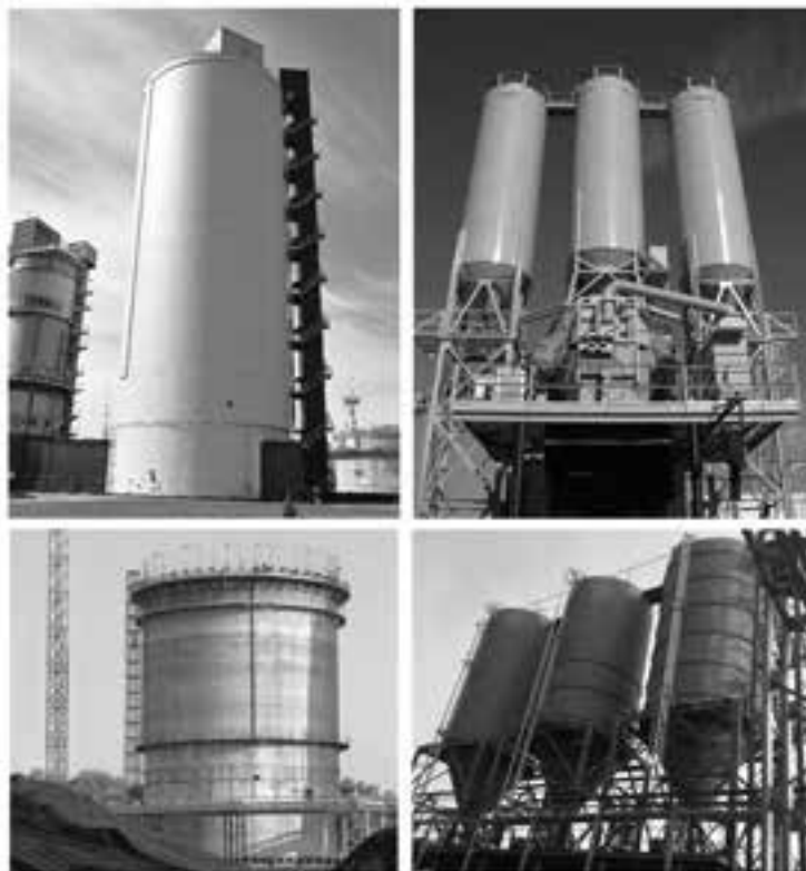
Rys. 7.2 Silosy na popioły lotne
