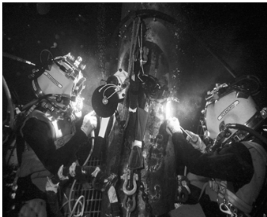
Rys. 9.8 Prace konstrukcyjne na dnie morza wykonywane przez nurków saturacyjnych platformy
