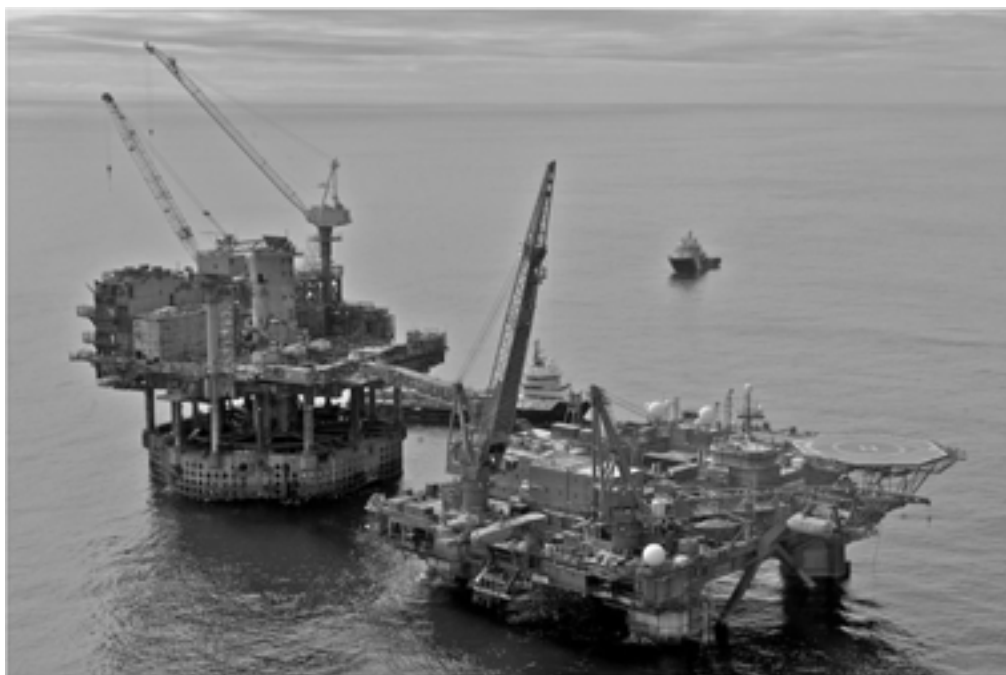
Rys. 9.12 Złomowanie nieużywanych instalacji wydobywczych
