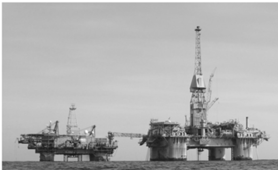
Rys. 9.7 MSV Regalia w trakcie pozycjonowania dynamicznego połączona mostem z zakotwiczoną platformą Visund
