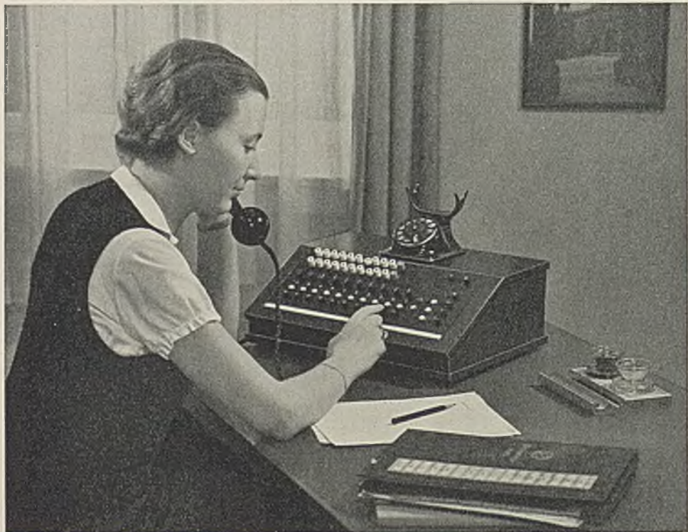
Abfragestelle einer Neha-Wählanlage für 10 Amtsleitungen und 90 Sprechstellen.
