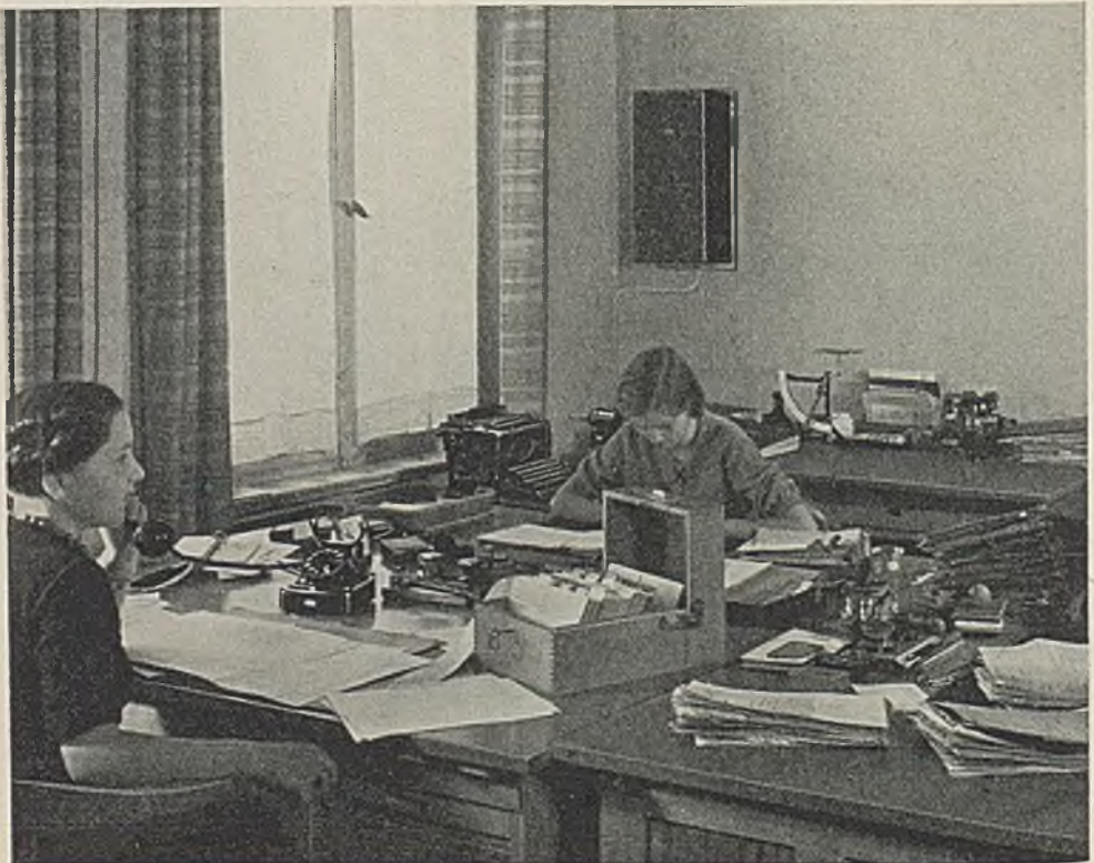
Neha-Wähleranlage für 1 Amtsleitung und 10 Sprechstellen einschl. Hauptstelle.
