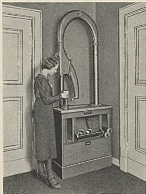
Tischstation einer Rohrpost-Weichenanlage für Empfang von unten. Absenden einer Büchse.
