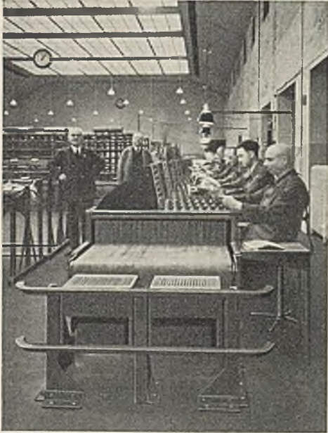
Hochkantverteilerwerk in einem Postamt.
