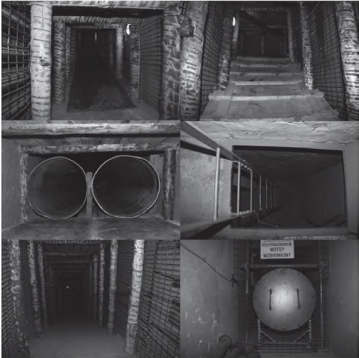
Rys. 21.15 Chodniki ćwiczebne – nachylone, z przełazem, lutniami, przedziałem drabinowym
