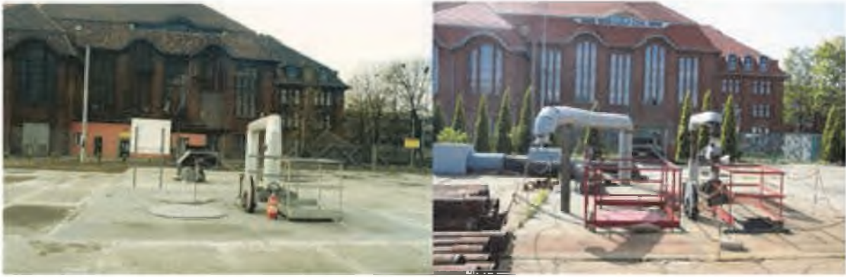
Rys. 11.2 Pompownia przed i po rewitalizacji budynku maszynowni [11]
