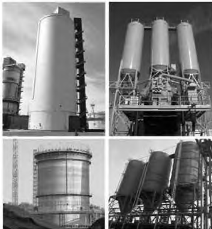
Rys. 7.2 Silosy na popioły lotne
