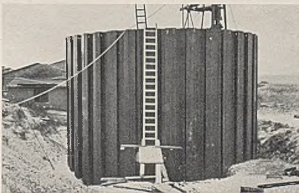
Abb. 7. Außenansicht des fertig angesetzten Spundwandringes.
