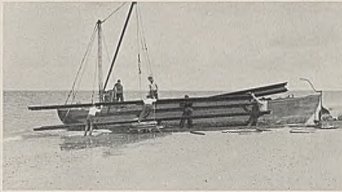
Abb. 6. Das Löschen der Spundbohlen am Strande der Düne.
