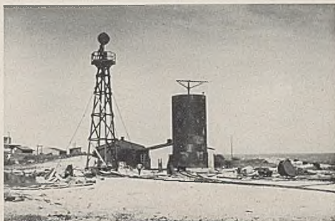
Abb. 13. Aufstellung des Turmes. Daneben die hölzerne Behelfsbake.
