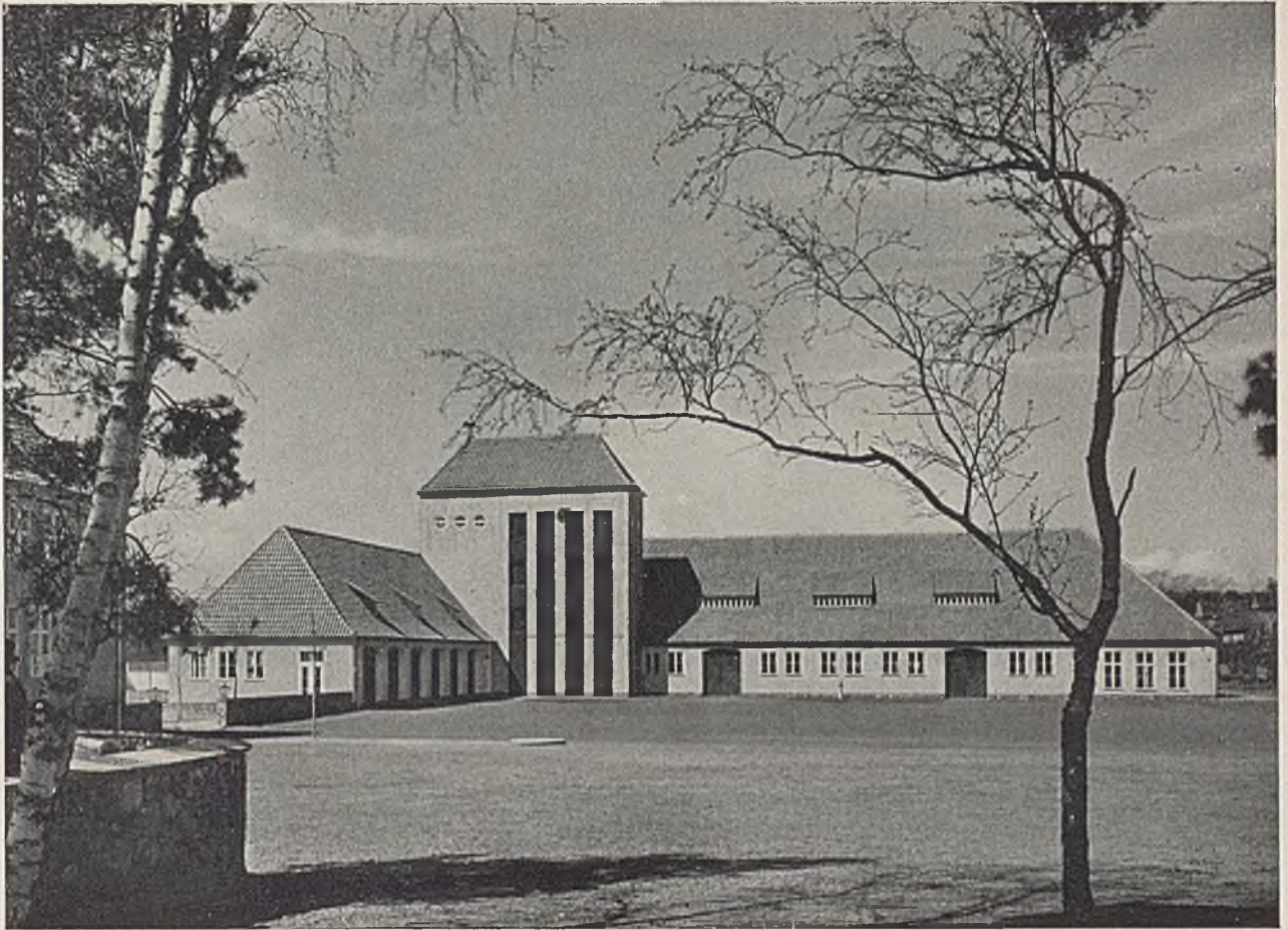
Blick über den Übungsplatz auf das Übungsgebäude. Links die Fahrzeughalle, in der Mitte der Steigerturm, rechts der Übungsflügel. Unten: Das Übungsgebäude, vom Wagenhof aus gesehen. Links die Garagen, in der Mitte die Schlauchwäsche, rechts die Fahrzeughallen.
