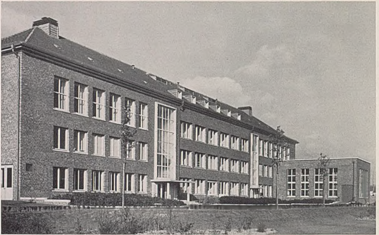
Die Haupteingangsseite. Rechts der flache Baukörper der Schmelzhalle mit dem sog. Bewitterungsdach. Als Steinmaterial wurden Hseklinker und Krenzheimer Muschelkalk verwendet.
