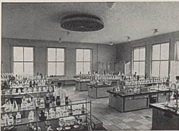
Das chemisch-analytische Laboratorium mit Deckenlüftung.
