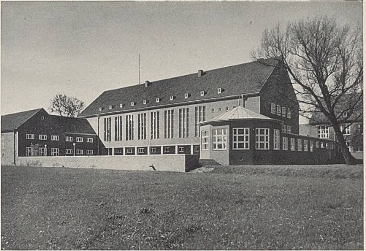
Das Festsaalgebäude, von Nordosten gesehen. Links anschließend das Musikgebäude. Rechts im Hintergrunde das Lehrgebäude 2. Der kleine Rundbau enthält einen Raum des Tagesheimes. Zwischen der Gartenhofmauer und der Wiese fließt — im Bilde nicht sichtbar — der Schwarzbach.
