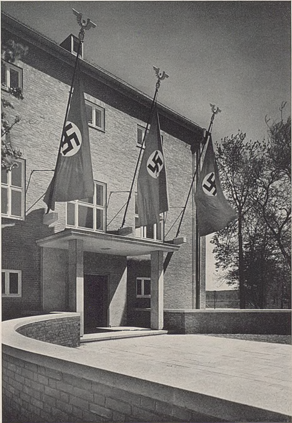
Eingang zum Festsaalgebäude. Ziegelmauerwerk aus Lauenburger Verblendern, Werksteinverkleidung in Muschelkalk.
