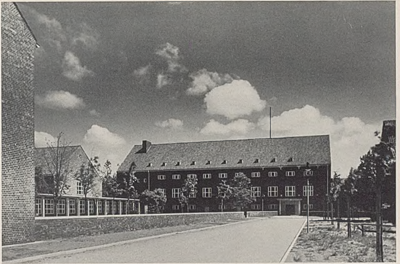
Blick von der Bernhard-Rust-Straße auf das Festsaalgebäude. Links am Rande der Giebel des Verwaltungsgebüdes.
