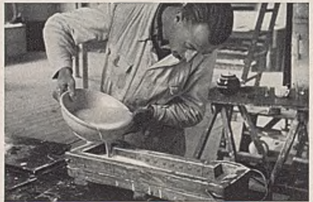
Abb. 1 (links). Der Gipszug. Mit Hilfe der Schablone werden aus der breiigen Gipsmasse die Profile eines Architekturteiles „gezogen“, hier z. B. ein langgestrecktes Satteldach der Ordensburg Vogelsang. Abb. 2 (rechts). Der Gipsguß. In die durch Schellack isolierte Negativform wird der Gips in leichtflüssigem Zustande eingegossen. Die Form besteht aus einzelnen, durch Drähte miteinander verklammerten Teilen, kann also nach Erstarrung der Gipsmasse leicht auseinander genommen werden.
