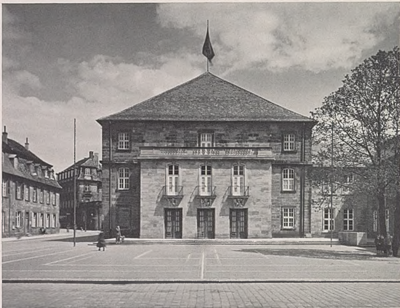
Der Haupteingang der Ludwig-Siebert-Festhalle am neugestalteten Jean-Paul-Platz. Unten: Der Zustand des Jean-Paul-Platzes vor der Neuplanung mit dem Denkmal Jean Pauls im Mittelpunkt (vgl. auch die Lagepläne auf S. 956 u. 957).
