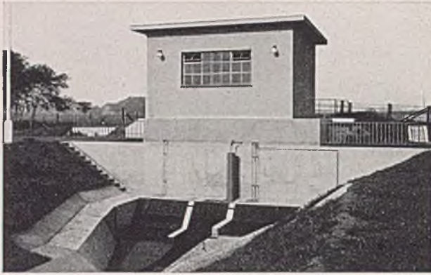
Abb. 19. Ansicht des Pumpwerkes Herringen.
