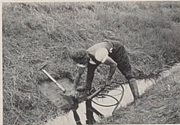
Abb. 30. Der Rieselwärter verschließt einen Entwässerungsdrän durch eine Gummiblase.
