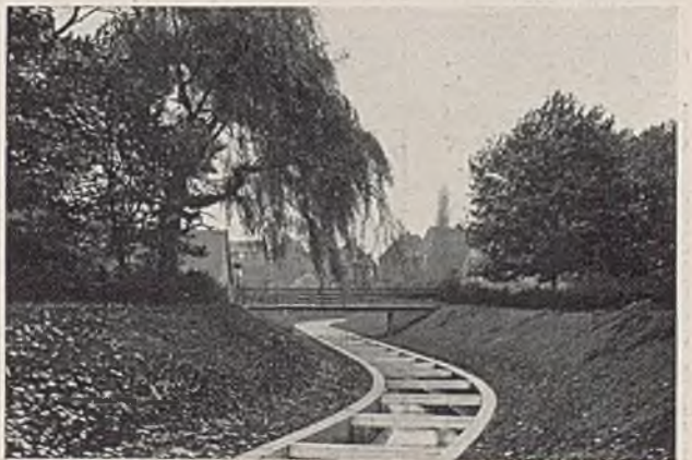
Abb. 18. Vertiefter Dattelner Mühlenbach innerhalb von Datteln. Durch Eisenbeton geschützte stählerne Leichtprofile.
