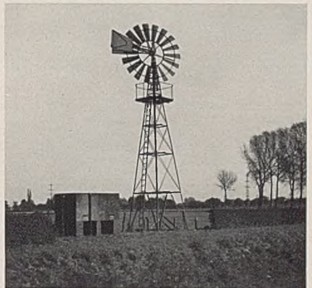
Abb. 11. Tränkbecken, gespeist durch windradgetriebene Pumpe.
