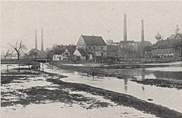
Abb. 6. Abgesunkener Körnelauf bei Kurl.
