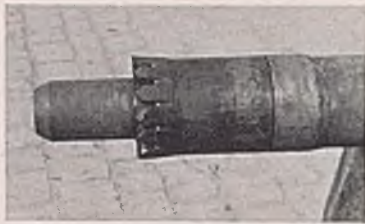
Abb. 5. Doppelstoß-bohrkernmeißel.
