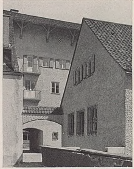
Blick von Süden auf die Hofseite und die Durchfahrt.
