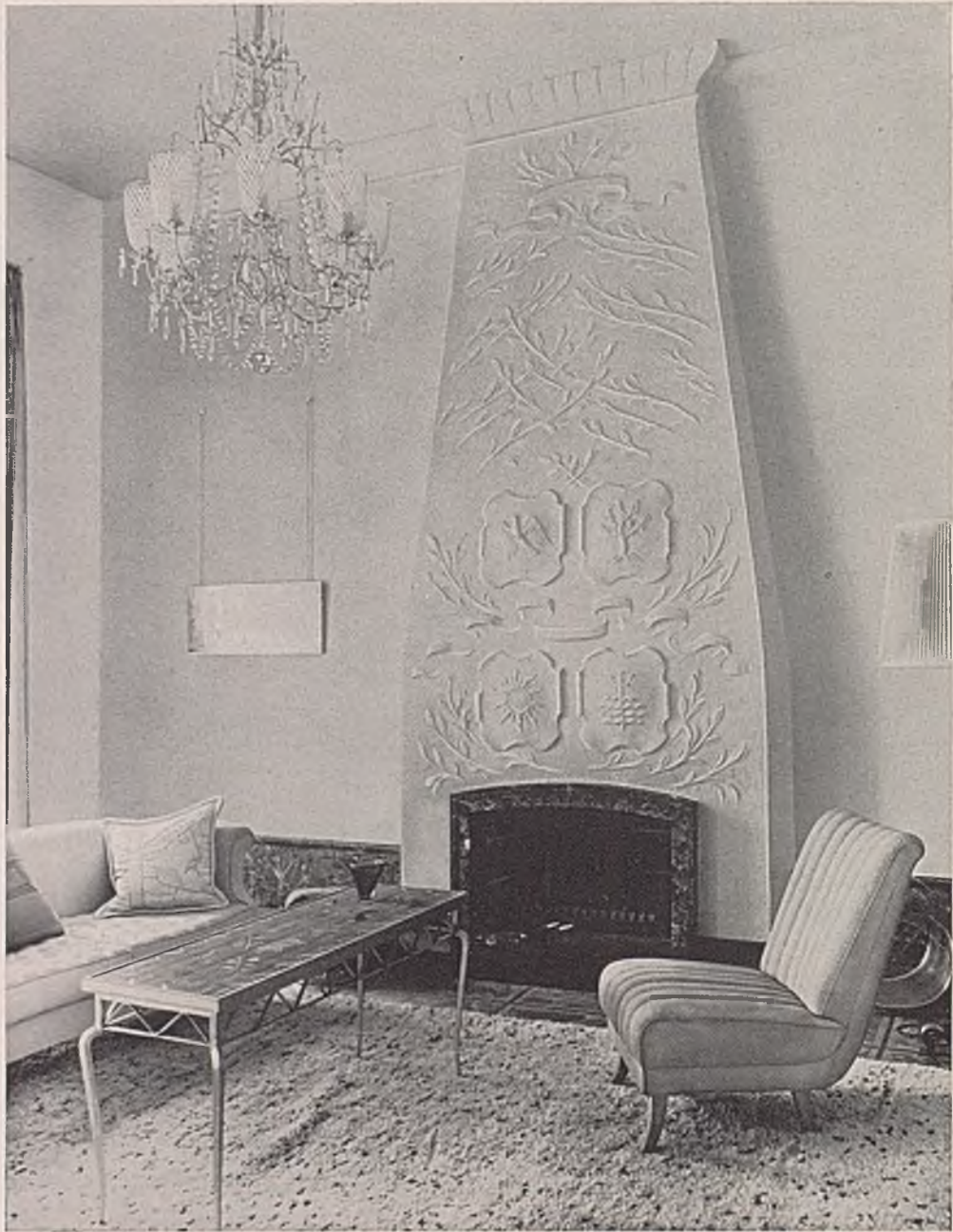
Stuckarbeiten in den Empfangsräumen der Reichspost in der Hakeburg. Kamin mit angetragener Stuckarbeit. Wände und Decken glatt weiß stuckiert.
