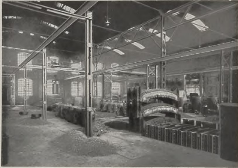
Abb. 418. Temperofenanlage unter Flur.
