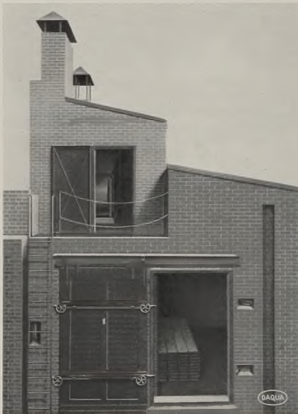
Abb. 762. Ansicht einer Kammertrockenanlage für Holz.
