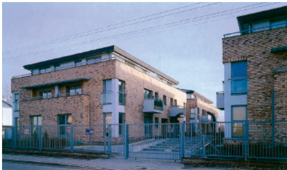
Figure 7. Rezydencja Syta Apartment Complex, ul. Syta 99, Warszawa (designed by M. Sondij, J. Wolański), fragment of the eastern frontage of the complex. Source: “Architektura-Murator” no 3, 2004 p.63; Photo: W. Kryński
