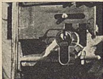
Bild 210. Befestigung des Einbau-Doppelzylinders
