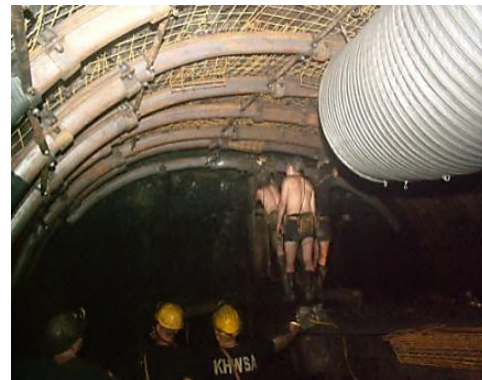
Rys. 6. Zabudowa połączonych łuków stropnicowych w przodku
