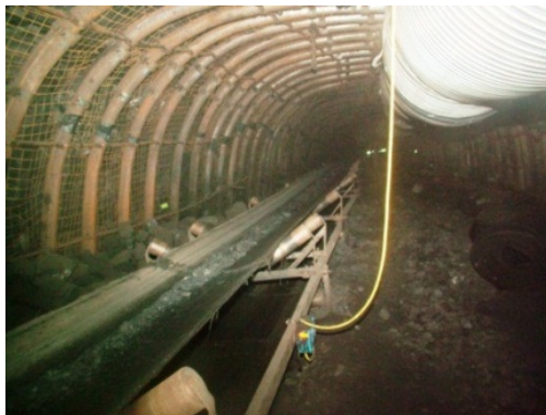
Rys. 5. Odstawa urobku przenośnikiem taśmowym w przecince
