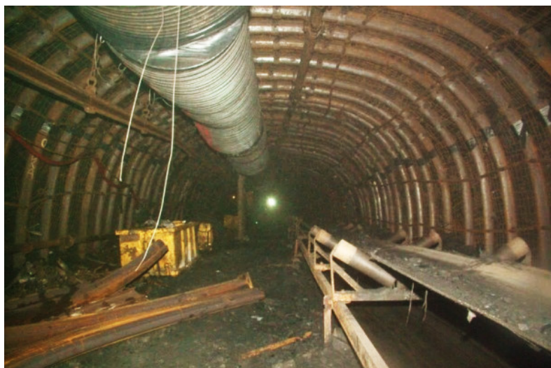
Rys. 9. Widok przecinki ściany 301 w pokładzie 318 w obudowie ŁPSPV32/4/7, 2x3,8 m, szerokość 7,2 m, wysokość 3,8 m
