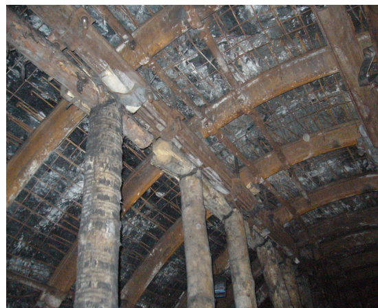
Rys. 14. Widok wzmocnienia obudowy chodnika 20a za frontem ściany poza strefą oddziaływania krawędzi pokładu
