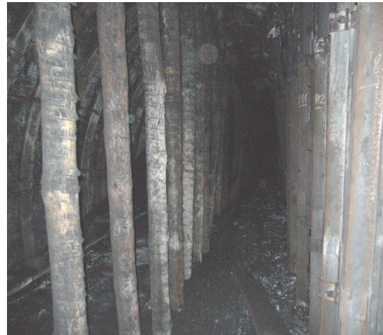
Rys. 16. Widok chodnika 20a za frontem ściany poza strefą oddziaływania krawędzi pokładu
