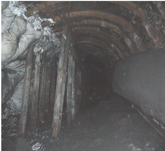
Rys. 15. Widok chodnika 20a za frontem ściany w strefie oddziaływania krawędzi pokładu
