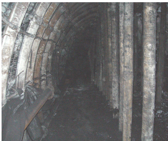
Rys. 13. Widok wzmocnienia obudowy chodnika 20a za frontem ściany poza strefą oddziaływania krawędzi pokładu
