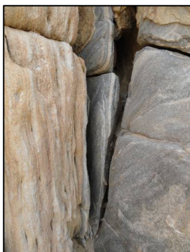
Rys. 21. Szczeliny powstałe wskutek ruchów tektonicznych w marmurach Fig. 21. Tectonic gaps in marbles
