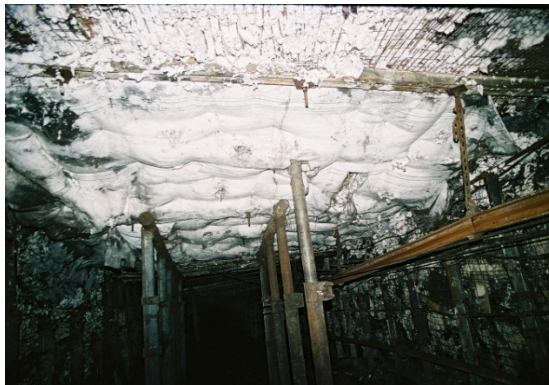
Rys. 8. Wypełniona pustka stropowa ze wzmocnieniem obudowy Fig. 8. Filled roof cavity with strengthening of support
