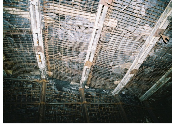
Rys. 11. Zginanie z wyboczeniem i skręceniem stropnicy na długości Fig. 11. Bending with buckling and torsion oblong of roof bar
