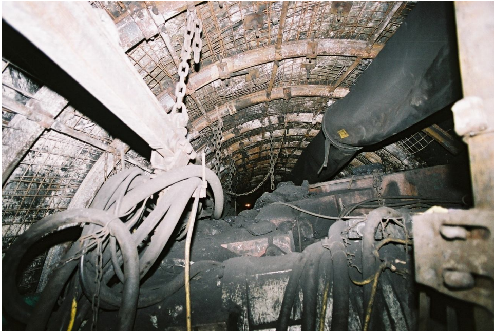
Rys. 5. Widok skrzyżowania ściana-chodnik z przykotwionymi odrzwiami za pomocą dwóch par kotwi
