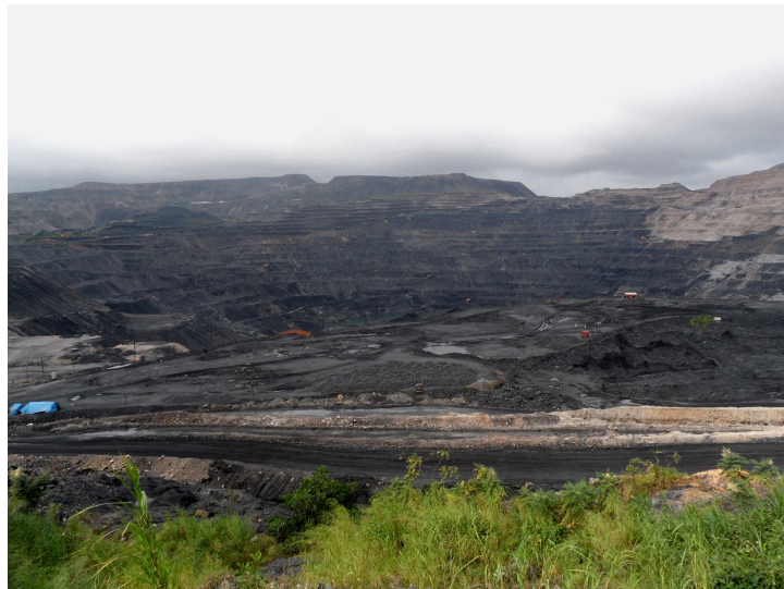
Fot. 1. Widok ogólny kopalni Coc Sau (fot. P. Strzałkowski) Phot. 1. General view of open pit Coc Sau
