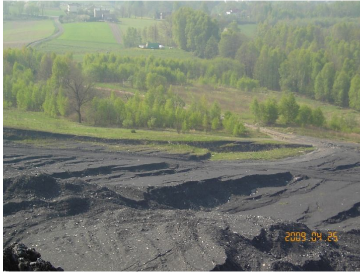
Fot. 1. Deformacje nieciągłe na skarpie składowiska odpadów pogórnich Photo 1. Discontinuous deformations in the slope of the landfill mining wastes
