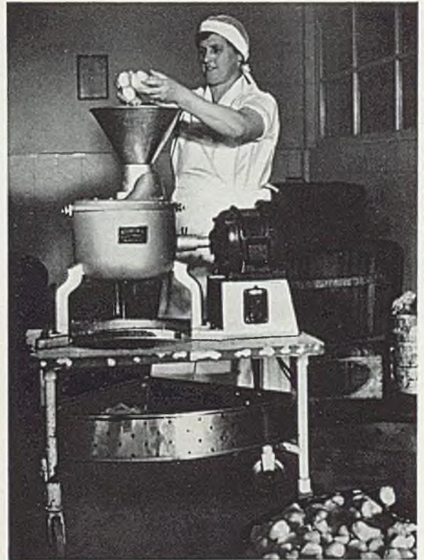
Abb. 71 Universal-Küchenmaschine zum Reiben, Schneiden und Schnitzeln pflanzlicher Produkte
