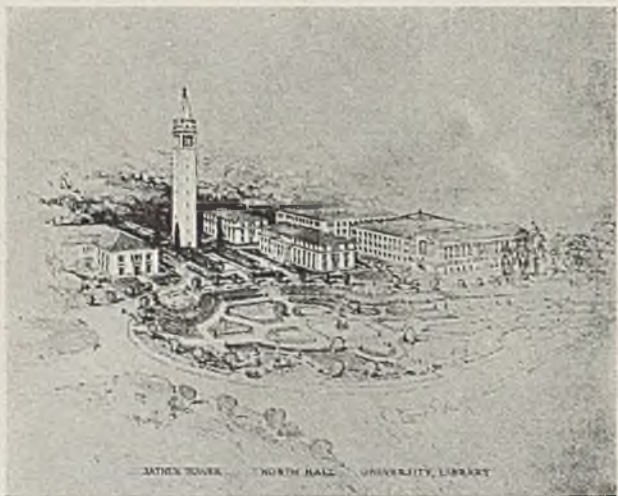
ABB. 337. — CAMPANILE, NORDHALLE. BUCHEREI
