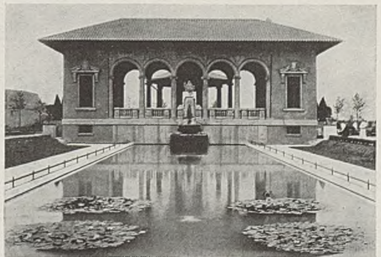
ABB. 538. — HOBOKEN. HALLE IM HUDSON COUNTY-PARK Architekt: Arthur Ware. Vgl. Abb. 537.
