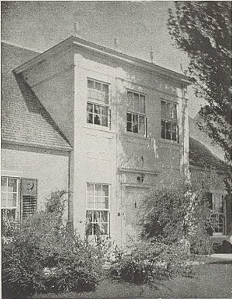
ABB. 568. — LOS ANGELES HAUS DES ARCHITEKTEN T. BEVERLEY KEIM Erbaut etwa 1924.
