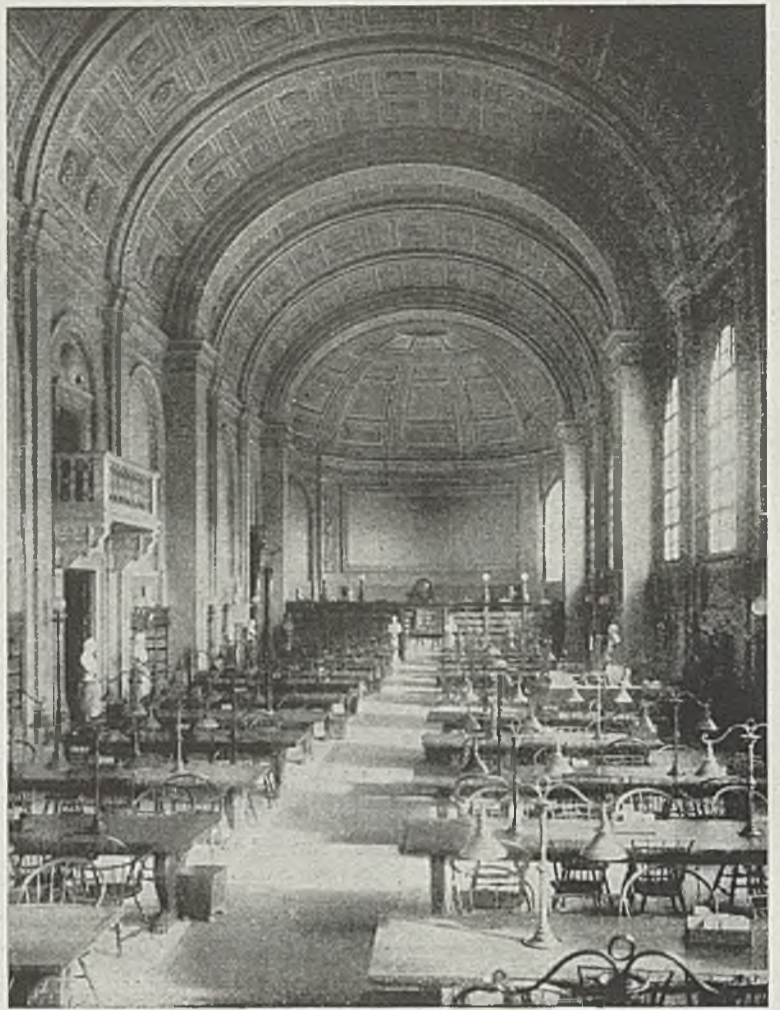
ABB. 706. — BOSTON. LESESAAL DER ÖFFENTLICHEN BÜCHEREI, 1898 Architekten: McKim, Meat und White. (Vgl. Abb. 236, 720—723.)
