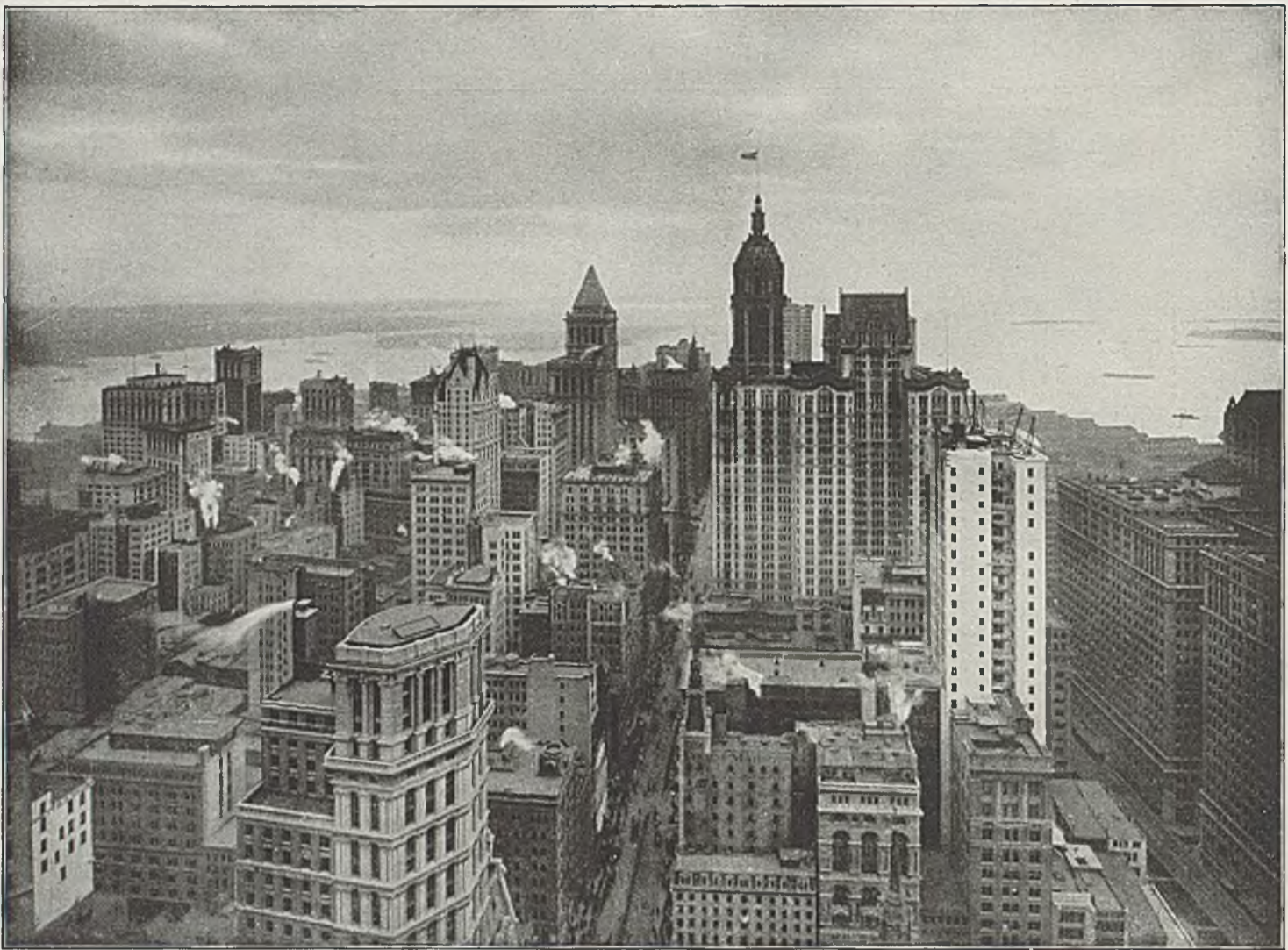
ABB. 162. — NEW YORK. WOLKENKRATZERWÜSTE SÜDLICH DES WOOLWORTH GEBÄUDES IM JAHRE 1914
