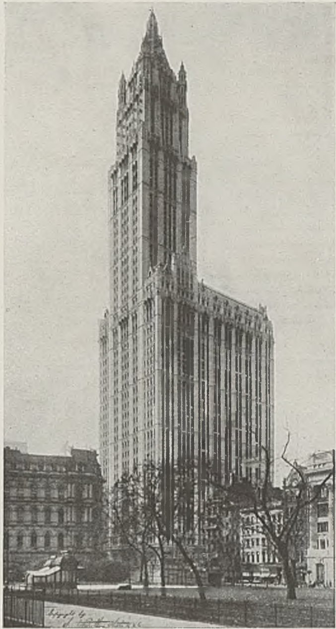
ABB. 685. — NEW YORK, WOOLWORTH GEBÄUDE 1913
