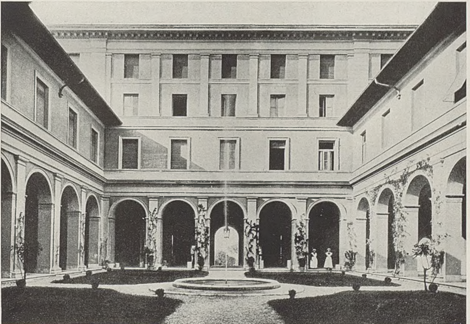
ABB. 577. — ROM. AMERIKANISCHE AKADEMIE Erbaut 1913. Vgl. die Außenansicht Abb. 232, S. 65 und die Grundrisse Abb. 577A u. B auf S. 152. Architekten: McKim, Mead und White
