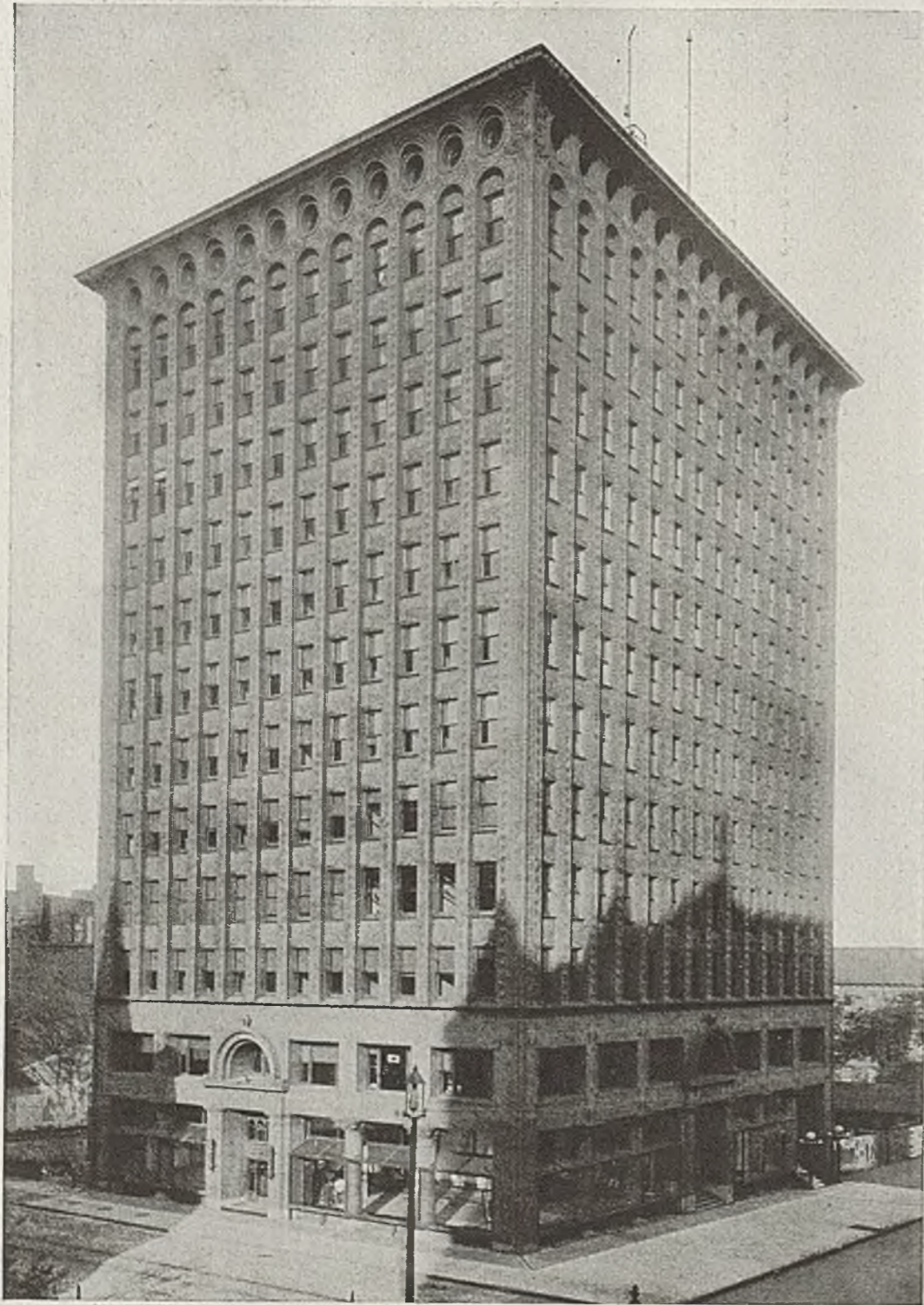
ABB. 724. — BUFFALO. GUARANTY (PRUDENTIAL) GEBÄUDE. ERBAUT 1896 Architekt: Louis Sullivan
