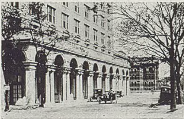
ABB. 243. — HOUSTON (TEXAS). ARKADEN DES TEXAS COMPANY GEBÄUDES Architekten: Warren und Wetmore.
