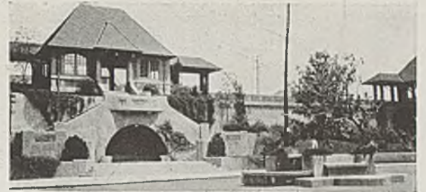
ABB. 177. — NEW YORK, FOREST HILL GARDENS HOCHBAHN-HALTESTELLE
