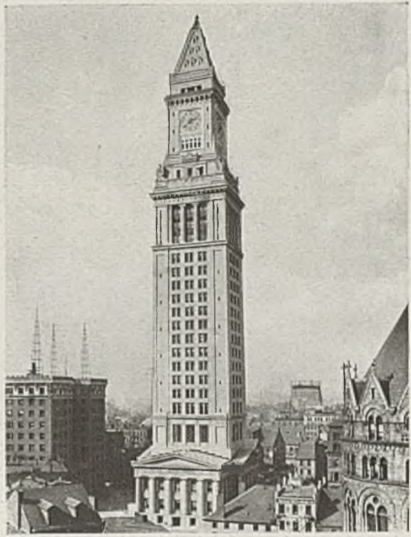
ABB. 119. — BOSTON. ZOLLHAUS Architekten: Peabody und Stearns.
