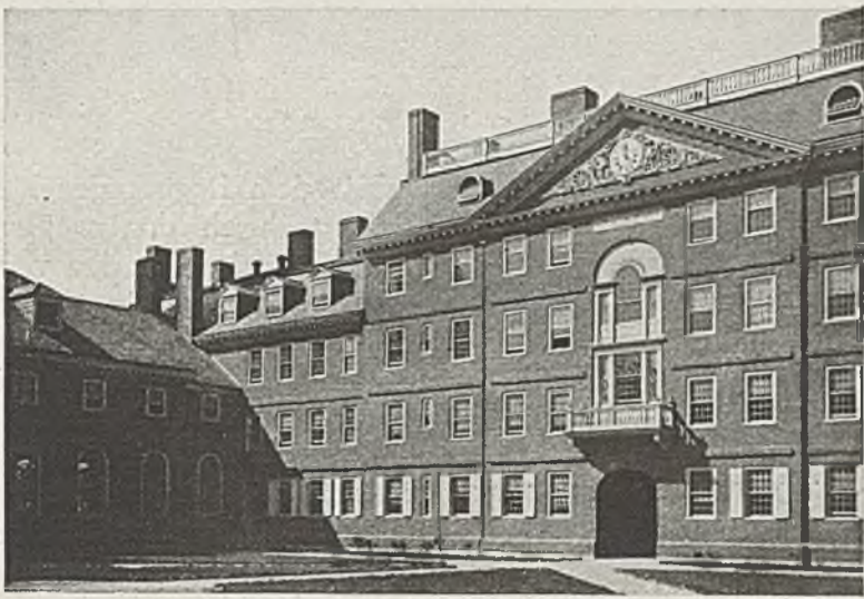
ABB. 392. — CAMBRIDGE. SMITH HALLS (Vgl. Abb. 387—390) Architekten: Shepley, Rutan und Coolidge.
