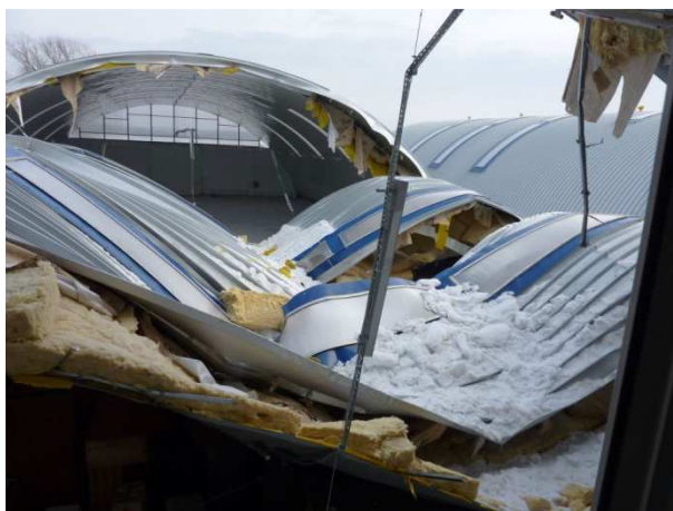
Rysunek 4. Przykład zawalonej hali w systemie ABM 120
