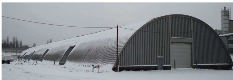
Rysunek 3. Hala łukowa wykonana w technologii ABM
