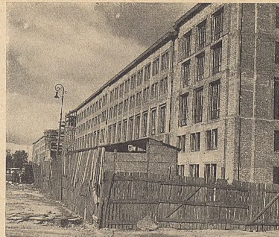
Rys. 89. STAN SUROWY REALIZACJI OD STRONY ZACHODNIEJ WEDŁUG STANU Z WRZEŚNIA 1952 r.
