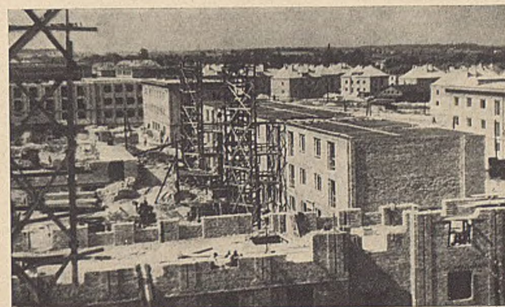
RYS. 236. WIDOK OGÓLNY FRAGMENTU NOWEJ HUTY W BUDOWIE
