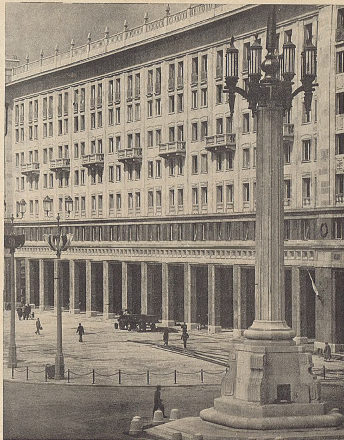
RYS. 152. BLOK 1 PRZY PLACU KONSTYTUCJI
