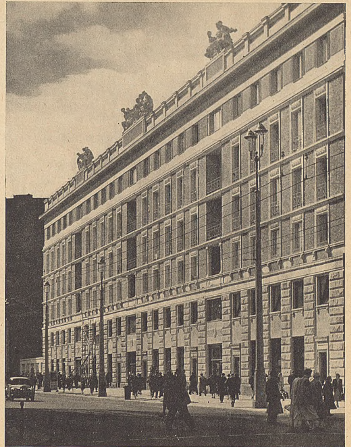
RYS. 175. ELEWACJA GŁÓWNA BLOKU ZACHODNIEGO PRZY UL. PIĘKNEJ
