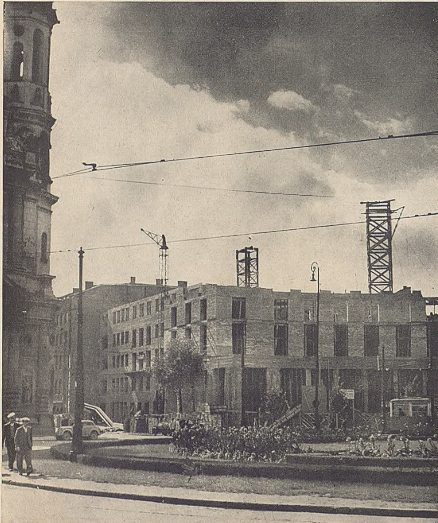
RYS. 196. BLOK 7 W REALIZACJI WEDŁUG STANU WE WRZEŚNIU 1952 R.
