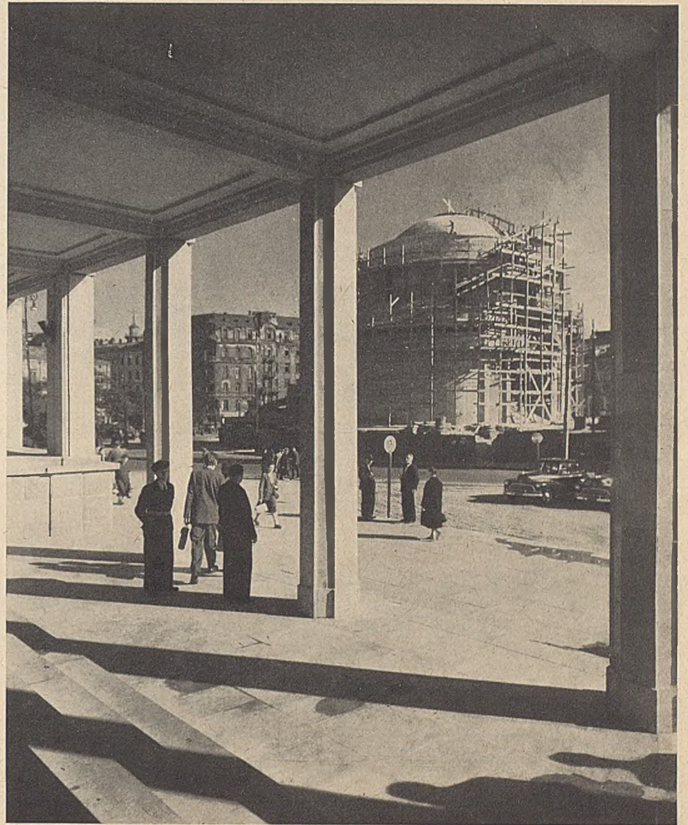
RYS. 32. WIDOK Z PODCIENIA PAWILONU I NA KOŚCIÓŁ ŚW. ALEKSANDRA W ODBUDOWIE
