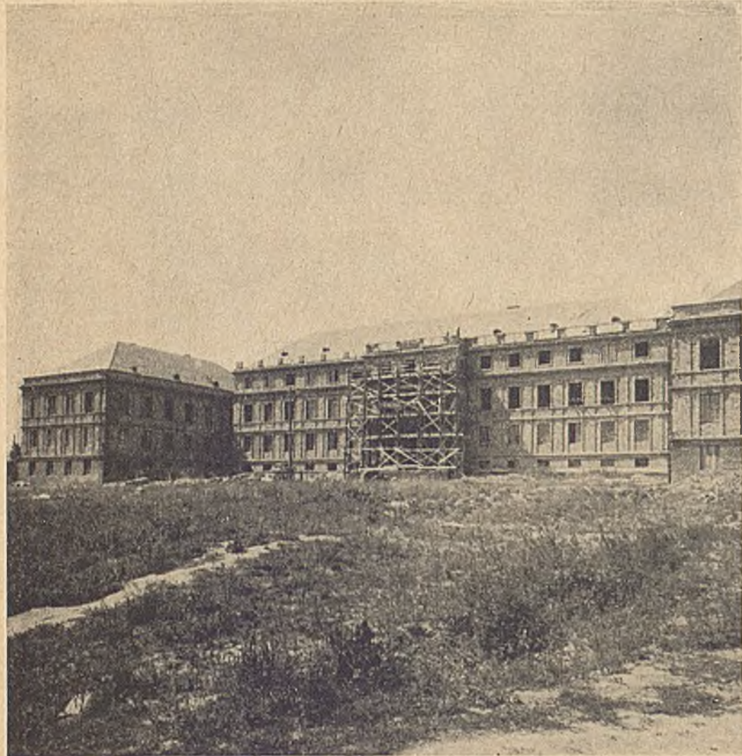
RYS. 98. STAN SUROWY REALIZACJI OD POŁUDNIA
