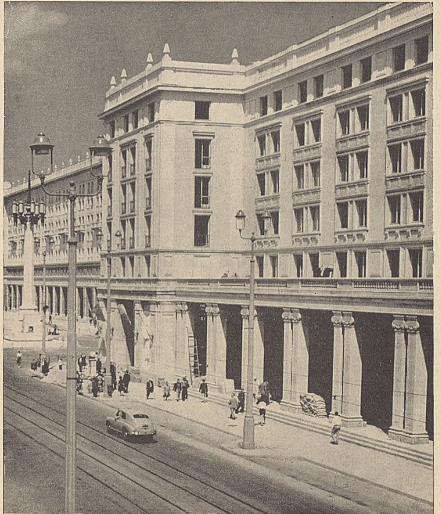
RYS. 167. FRAGMENT ELEWACJI BLOKU 2
