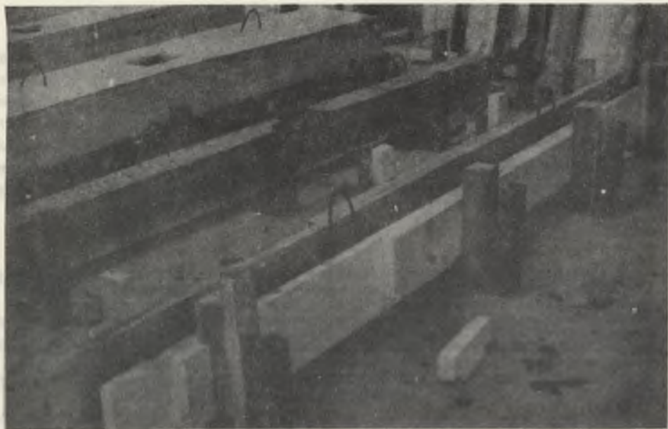
Rys. 1. Widok przygotowanych form w trakcie wykonywania ciał próbnych
