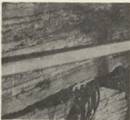
Rys. 2. Faza rozruchu ściany, widoczne silne zaciskanie wyrobiska (warziant 1)
