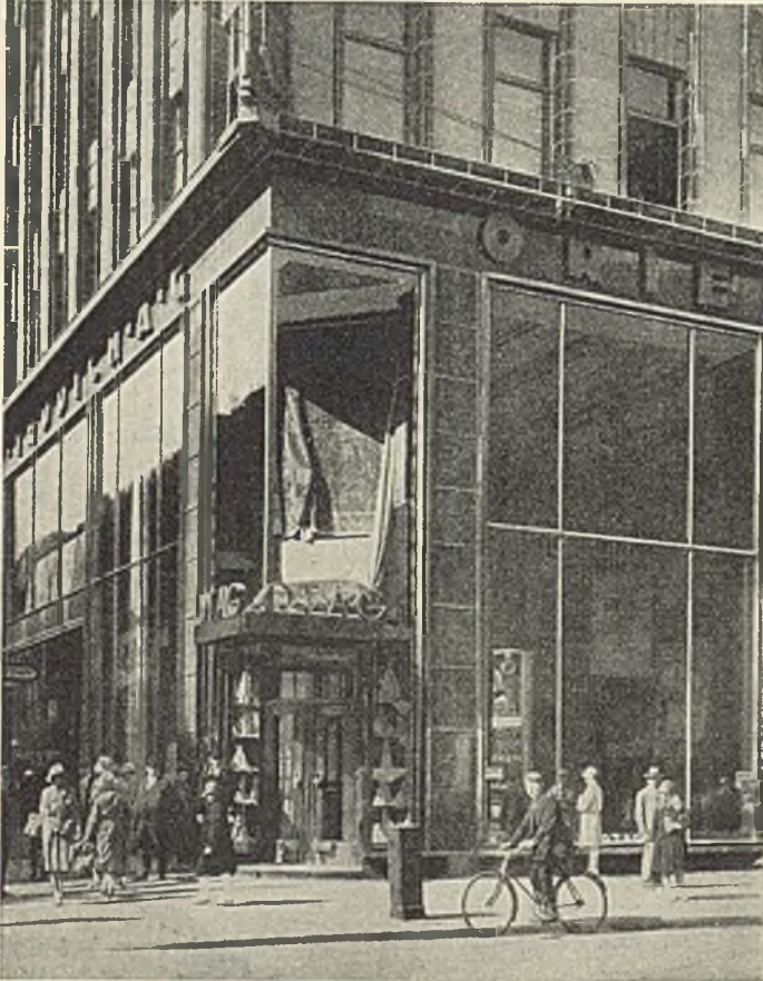
Abb. 307. Laden des Orient-Teppichhauses, Berlin. Arch.: Joh. E. Schaudt, Berlin. (Aus Paulsen: Kupfer, Messing, Bronze in Geschäftshäusern.)
