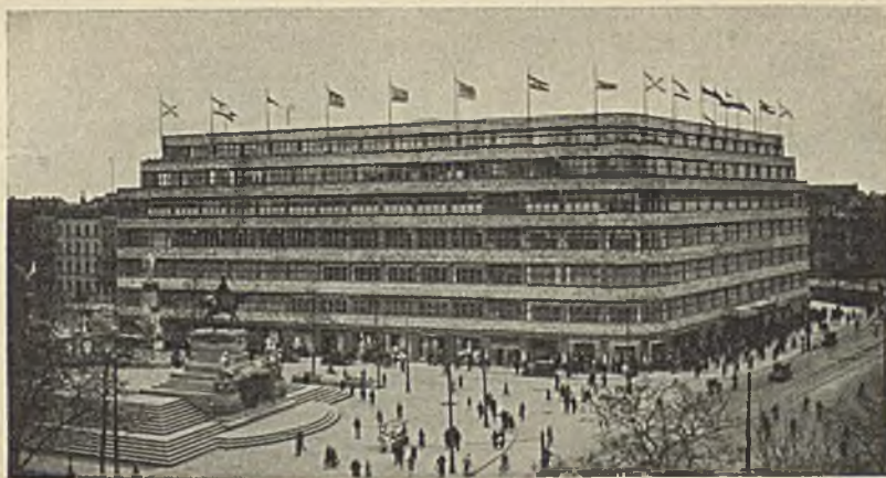
Abb. 2. Warenhaus Wertheim in Breslau. Arch.: Prof. Dernburg. Ausführung des Stahlskelettes: Carlshütte A. G., Waldenburg-Altwasser i. Schl.
