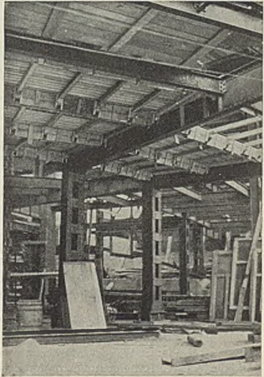
Abb. 334. Hochhaus der Berg- und Hüttenwerks-Ges. in Prag. Aufhängung der Decken- und Trägerschalung. Entwurf des Verfassers. Ausführung: Brückenbauanstalt Karlsbütte bei Friedek.
