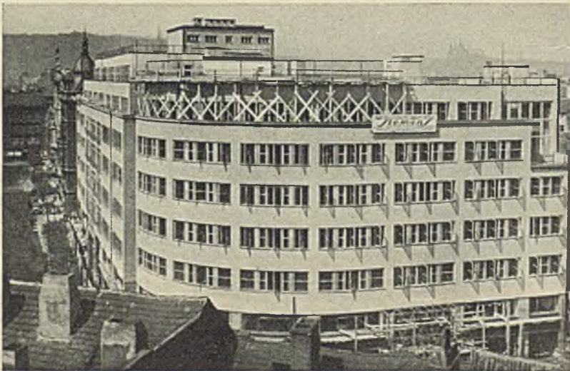
Abb. 4. Hochhaus der Berg- und Hüttenwerksges., Prag. Seitenansicht vor der Fertigstellung. Entwurf des Stahlskelettes: Prof. Dr.-Ing. A. Hawranek. Arch.: J. Rziha. Ausführung: Brückenbauanstalt Carlshütte bei Friedek.
