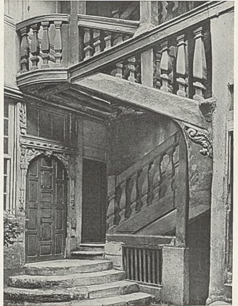
Treppe eines Hauses in der Rue Ampère zu Rouen
