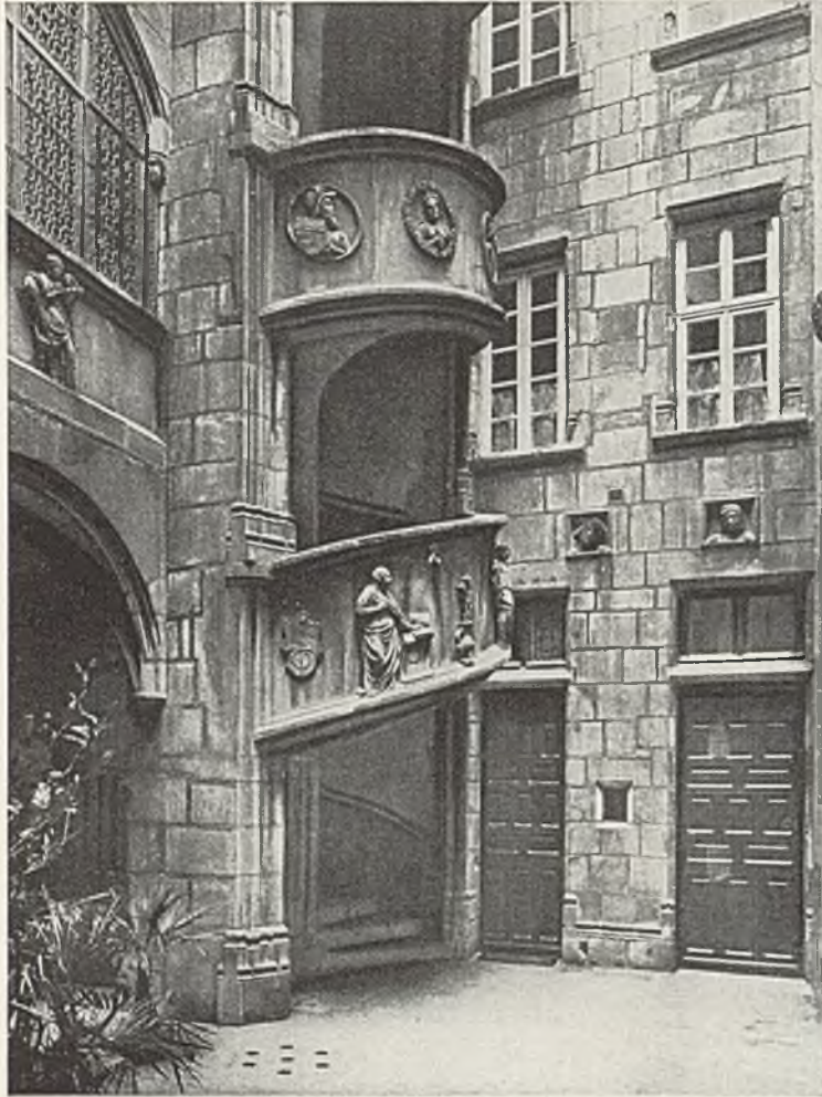
Treppenhaus im Hôtel de Montat zu Riom
