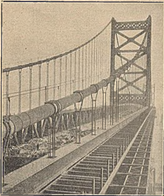
Rys. 21. Widok połączenia wieszaków z linami głównymi.
