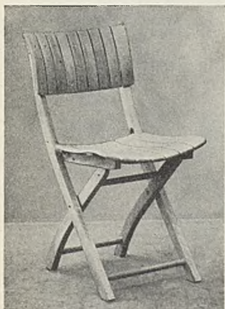
Abb. 782. Klappstuhl von großer Bequemlichkeit, bei welchem Sitz und Rückenlehne aus schmal gebogenen Leisten hergestellt wurden. (Modell der Firma Naether, Zeitz)
