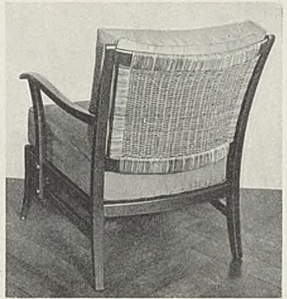
Abb. 454. Statt mit Quersprossen versehen, ist die Rücklehne hier mit Boondotrohr ausgeflochten
