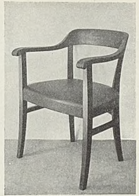
Abb. 133 u. 134. Schreibsessel aus Eichenholz für Massenerstellung auf halbrundem Grundriß und eingelegetem oder festgenageltem Flachpolstersitz. Rück- und Armlehnen sind aus drei Teilen verleimt oder werden in einem Stück gebogen. Entwurf: N.
