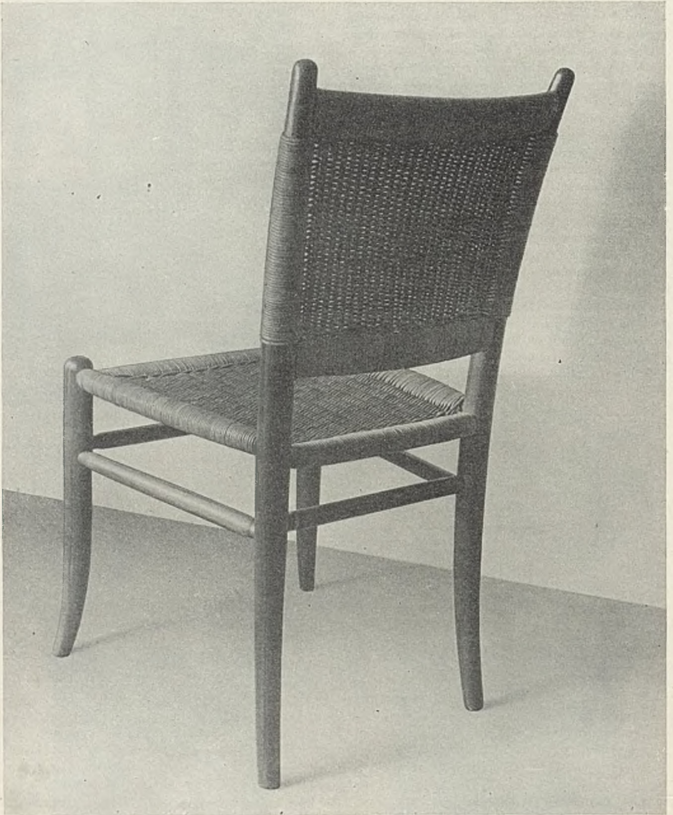
Abb. 56. Gedrechselter Stuhl aus Kirschbaum mit Boondotrohr ausgeflochten; die geschweiften Teile werden ausgearbeitet oder gebogen. Entwurf: N. Hersteller: R. Zeschke, Berlin
