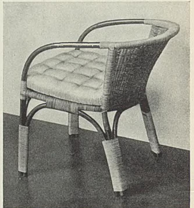
Abb. 760. Derselbe Sessel in kleineren Abmessungen und größerer Sitzhöhe, das Seitenteil ist offen und nur die Rückenlehne ausgeflochten. (Entwurf: N. Hersteller: Derichs, Coburg)
