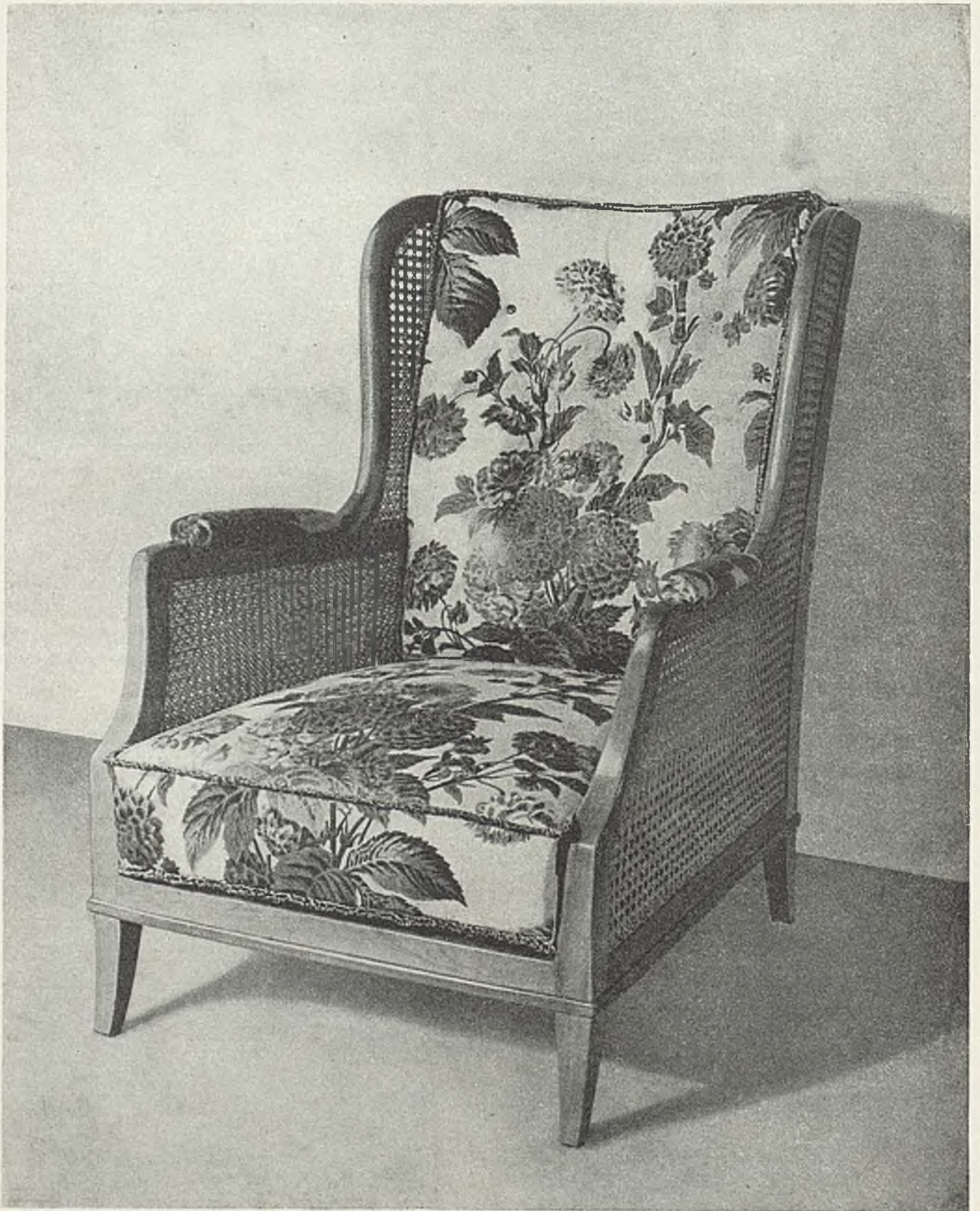
Abb. 456 (Entwurf: N. Hersteller: Zeschke, Berlin). Hochlehniger Ohrbackensessel für die Dame mit losem Sitz- und Rückenkissen. Das Gestell in eleganter Linienführung aus Mahagoni oder Birnbaum anpoliert, ist allseitig mit doppeltem Rohr ausgeflochten. Die Armlehnauflege ist mit einem kleinen Pölsterchen weich gemacht und verbrettert. Die Kissen sind hier mit einem großblumig bedruckten Chintz bezogen. Ein dicker und kräftiger Stoff eignet sich nicht für diesen Sessel.
