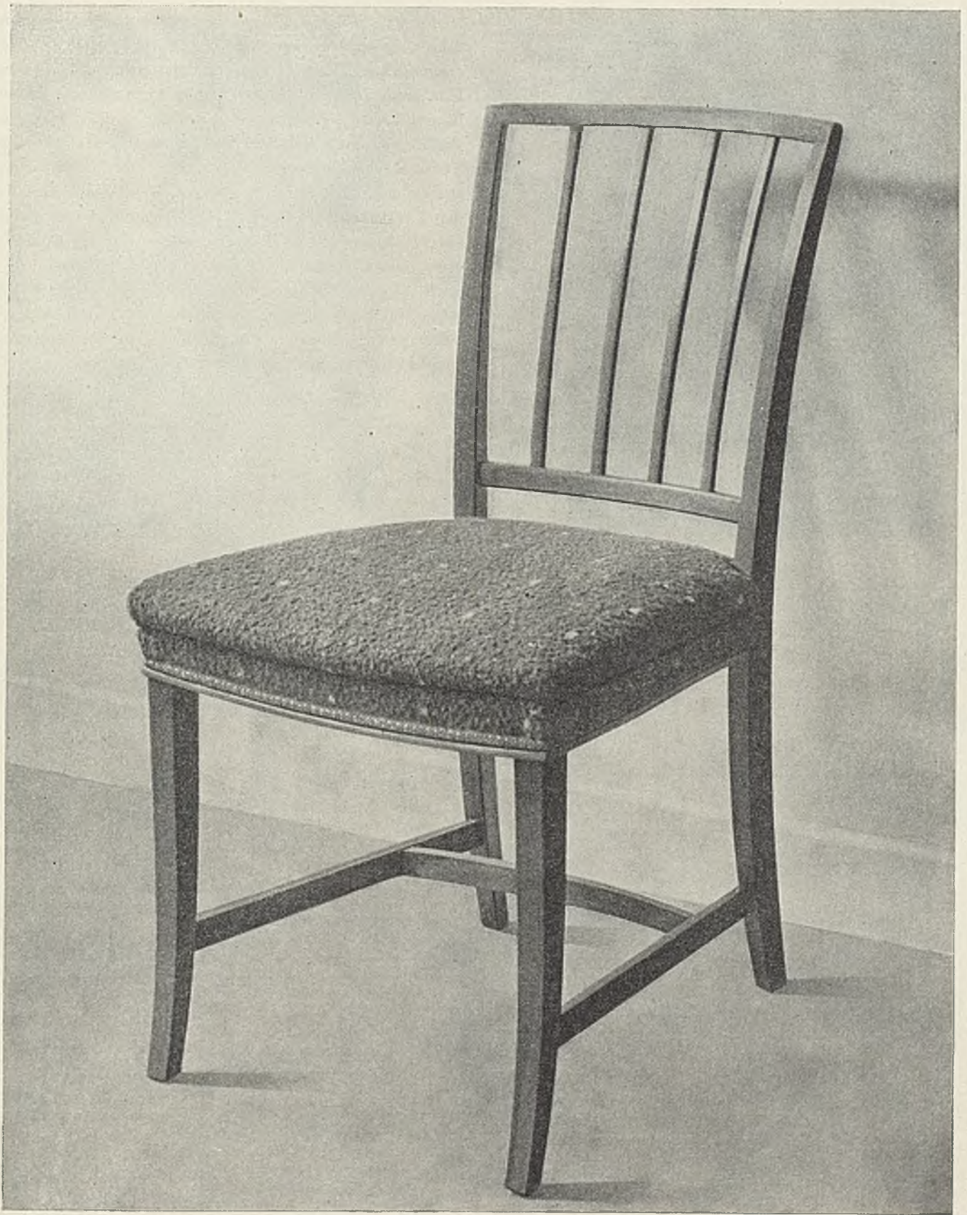
Abb. 281 (Entwurf: N. Hersteller: Zeschke, Berlin) zeigt einen Stuhl in hellem Nußbaum mit grünem Bezug, dessen Polsterung wie bei Abb. 277/278 ausgeführt ist. Im übrigen beachte man die harmonische Ausbildung aller Teile zueinander. (Der Bezug ist etwas zu grob)
