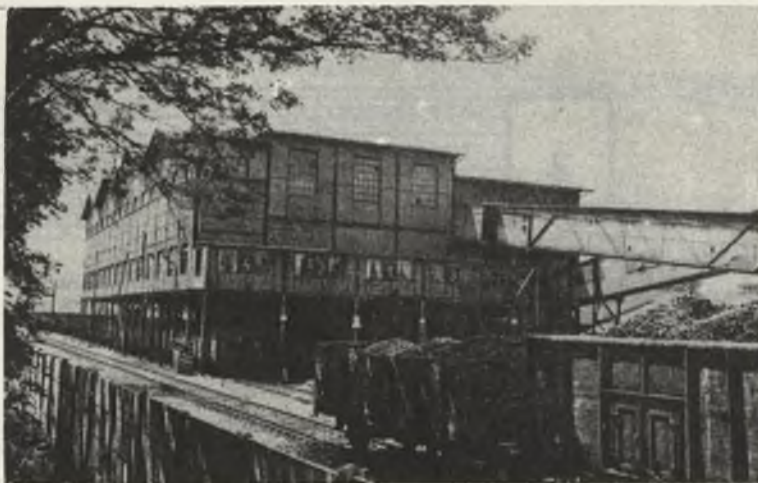
Rys. 21. Sortownia o konstrukcji szkieletowej w kopalni Murcki
