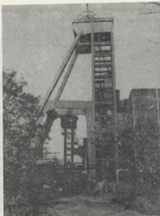
Rys. 14. Żelbetowa wieża wyciągowa kopalni "Prezydent" w Chorzowie
